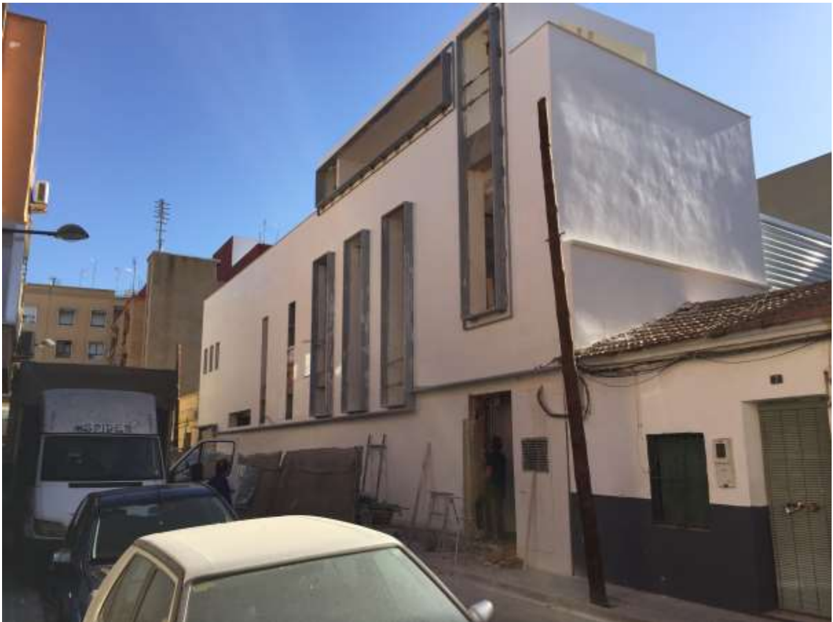
Figura 24. Vivienda unifamiliar objeto de estudio. Fuente propia. 2015
