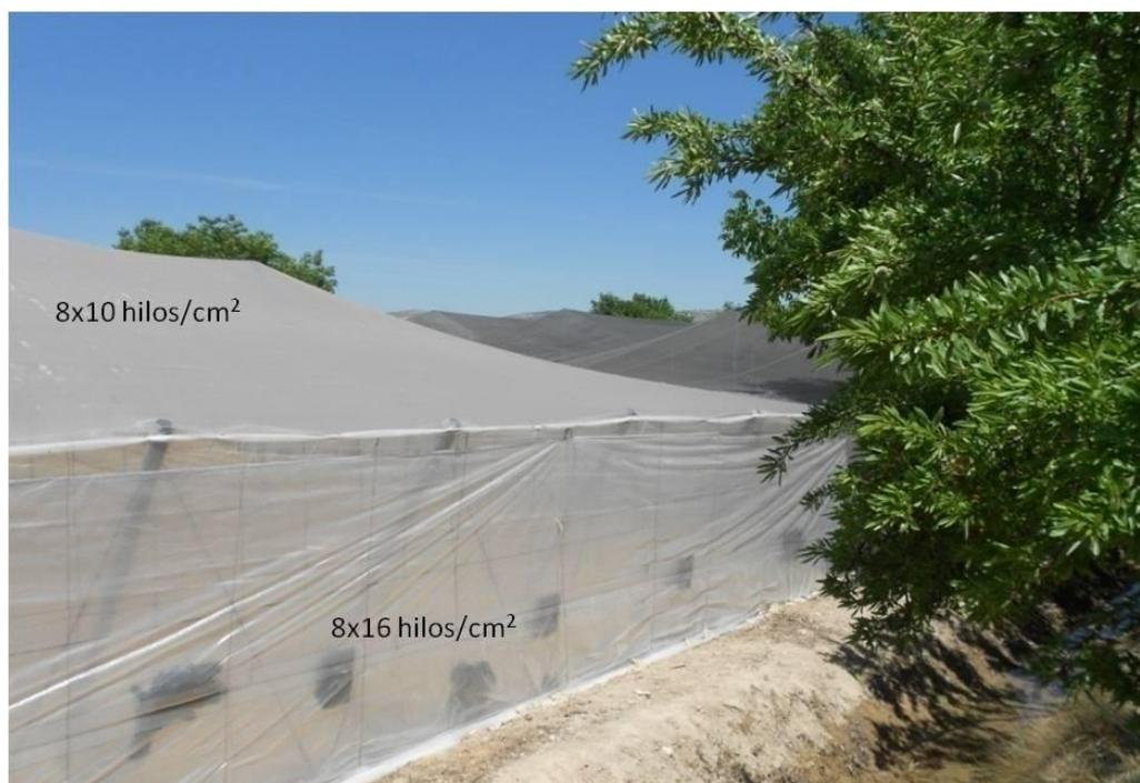
**Figura 15.** Malla de 8x16 perimetral empleada en el Sector 3 (izquierda) y malla 8x10 en el techo.
