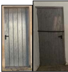
Ilustración 58: Puerta de acero posterior de la vivienda. Fuente propia.
