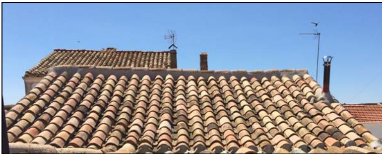
Ilustración 45: Cubierta principal a dos aguas y acabado en teja curva. Fuente propia.
