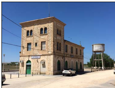
Ilustración 8: Estación de tren de Camorrobles. Fuente propia
