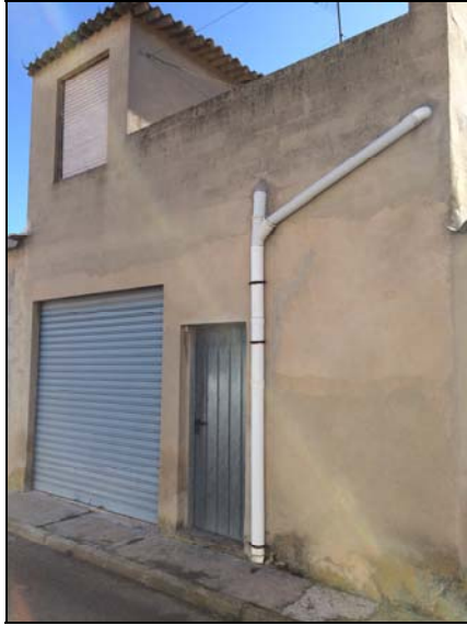
Ilustración 25: Fachada posterior vivienda. Fuente propia
