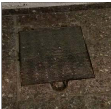
Ilustración 60: Pozo existente en la vivienda(40x40cm). Fuente propia
