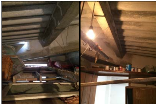
Ilustración 50: Estructura interior cubierta de la habitación 6 de la vivienda. Fuente propia.
