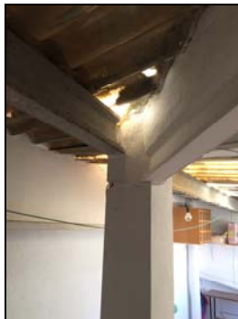
Ilustración 49: Estructura interior cubierta zona pública. Fuente propia.
