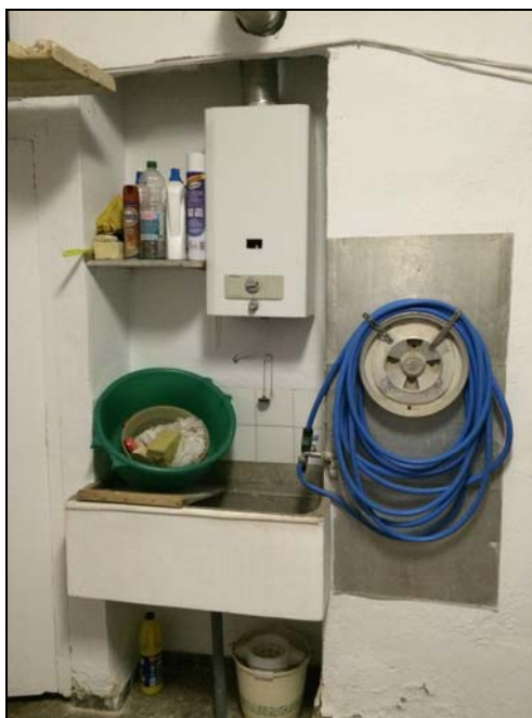
Ilustración 63: Equipamiento ACS existente en la vivienda. Calentador manual de gas butano. Fuente propia.
