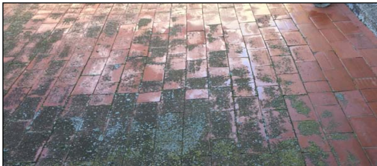
Ilustración 53: Terraza existente en vivienda. Fuente propia.
