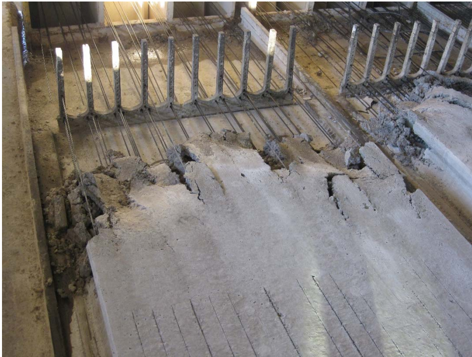
Fig. 3.6 Plantilla de alineación de cables (Imagen cedida por HORVITEN VALENCIA, S.A)
