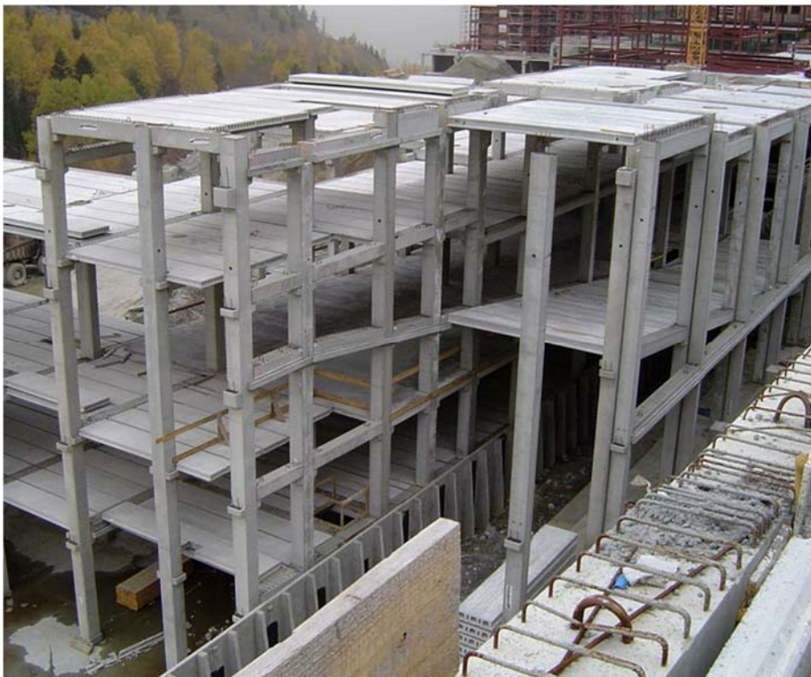
Fig. 1.3 Forjado placa alveolar. Edificación. (AIDEPLA 2016)
