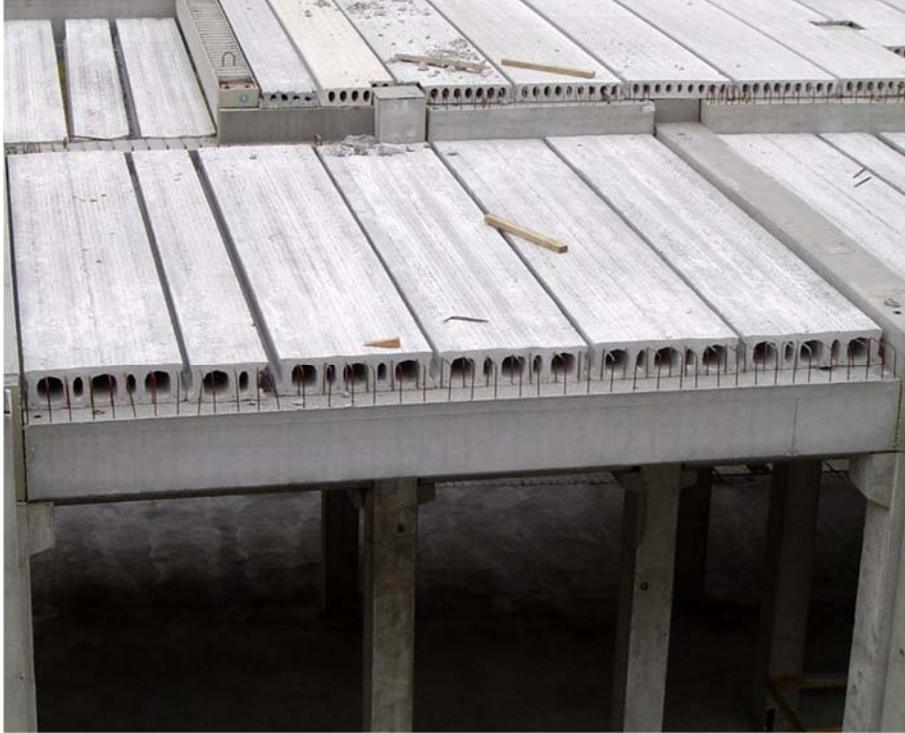
Fig. 1.2 Forjado placa alveolar. Garajes. (AIDEPLA 2016)
