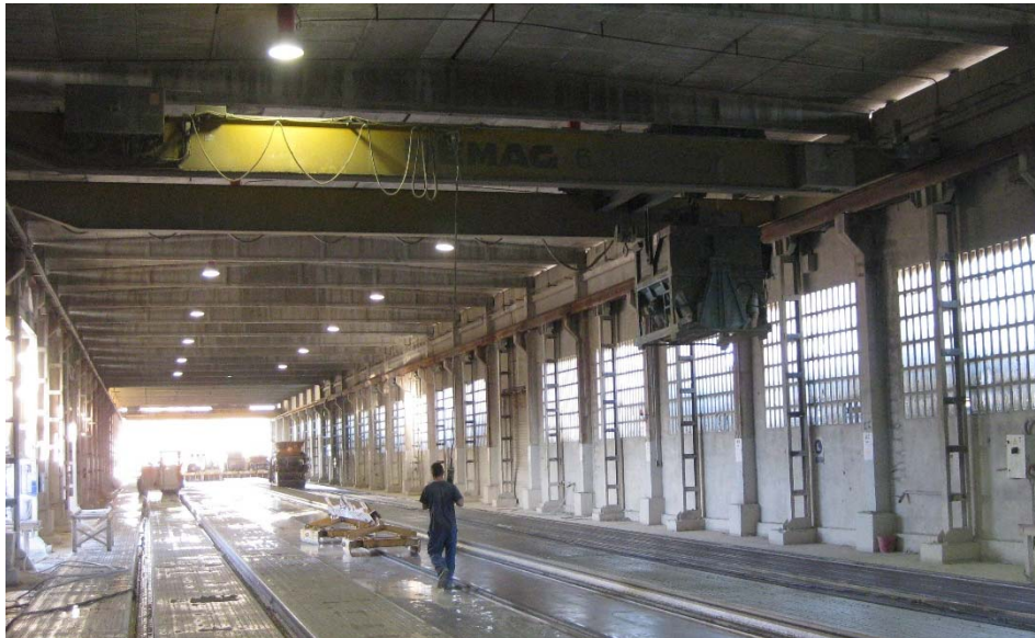
Fig. 3.8 Cubilote de transporte de hormigón (Imagen cedida por HORVITEN VALENCIA, S.A)
