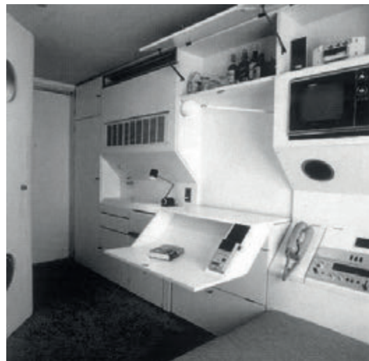
Fig. 24 Vista interior de una cápsula original donde se observa como todos los elementos mínimos de una vivienda quedan integrados en el elemento cerramiento.
