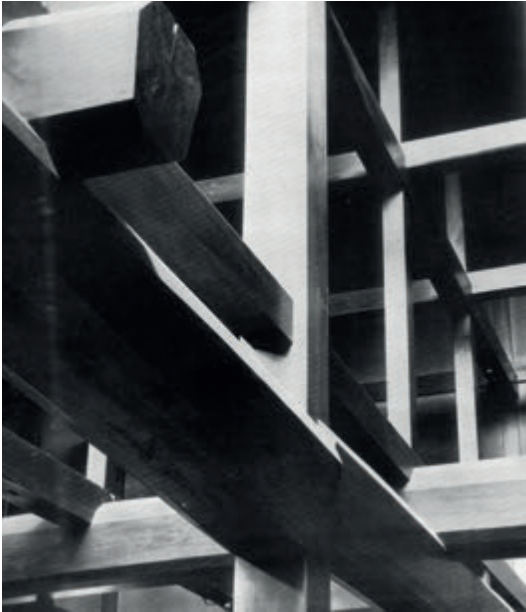
Fig. 2 Detalle de estructura de madera.
