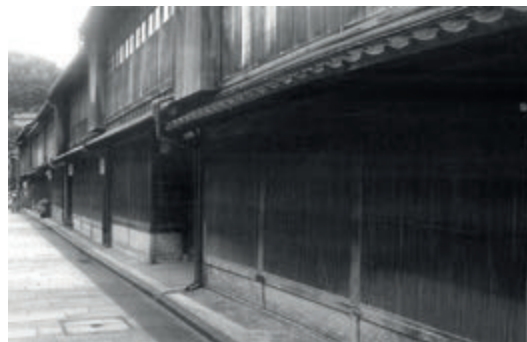
Fig. 11 Koshi en la calle Higashinochaya, Kanazawa. Los diferentes entramados componen las calles y permiten el paso de la luz y ventilar pero evitan miradas indiscretas.
