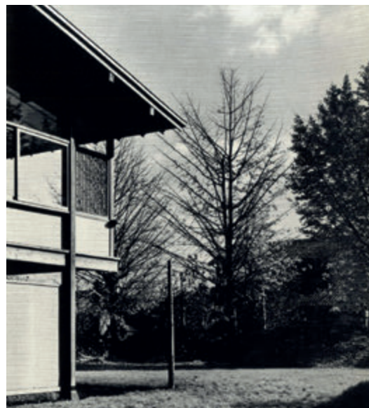
Fig. 7 Vista donde se percibe la prolongación de la cubierta en forma de alero.
