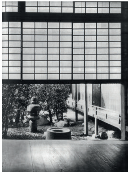
Fig. 27 Shoji con la parte inferior abierta. Casa de té Bosen. Kohoan templo Daitokuji, Kioto.
