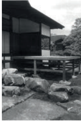
Fig. 7 Engawa del acceso al shoin de la villa Katsura con kutsunugi-ishi , roca elevada para descalzarse antes de entrar.
