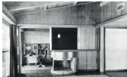
Fig. 2 Interior de la vivienda. Se observa la chimenea y unos de los pilares circulares. Al fondo se observa la estantería que conforma el estudio que además ejerce de partición con uno de los dormitorios.
