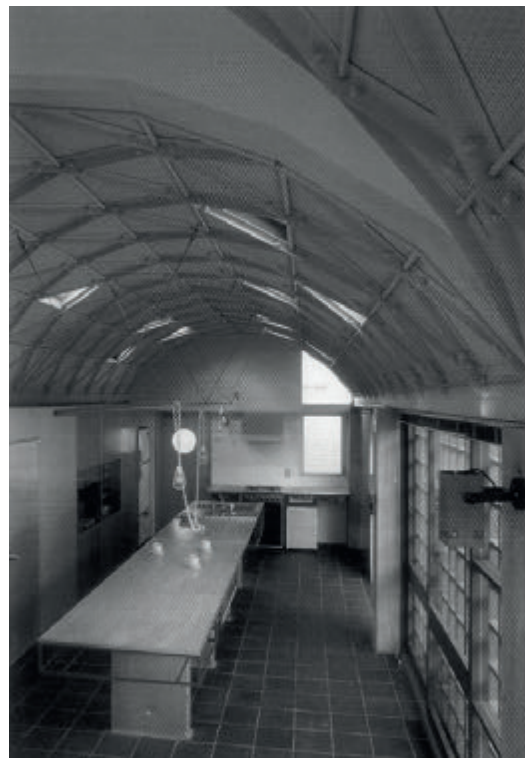
Fig. 41 Vista interior desde donde se puede observar las perforaciones en la cubierta.
