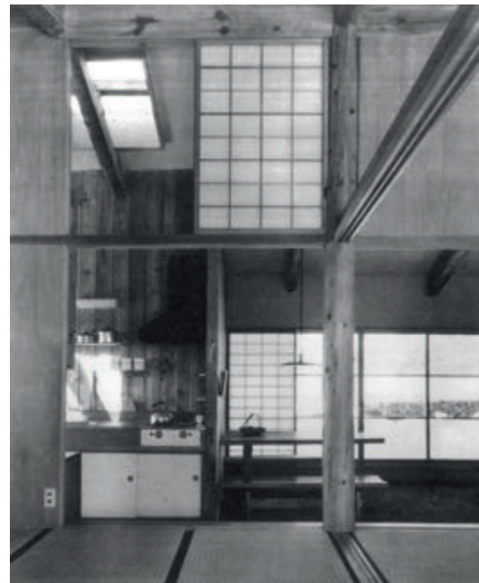
Fig. 14 Vista interior, desde la franja pavimentada mediante tatami, del pilar central de la vivienda. También se distinguen los rieles de los paneles correderos.
