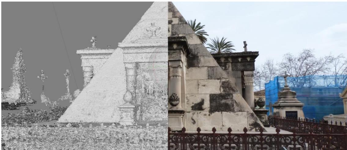
Ilustración 18. Imagen de un modelo fotogrametrico y fotografia del panteón Llovera.
