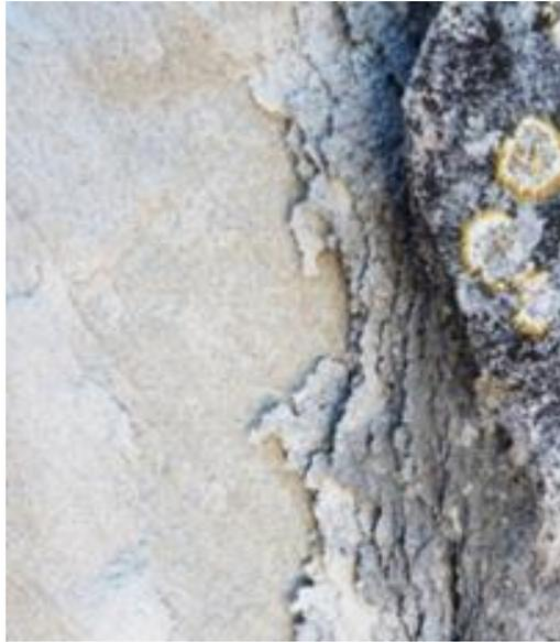
**Ilustración 9. Detalle de las degradaciones que afecta al panteón, costras negras y descohesión.**
