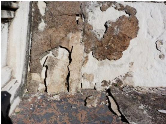
**Ilustración 10. Detalle de la pérdida del material, producida por los desprendimientos.**
