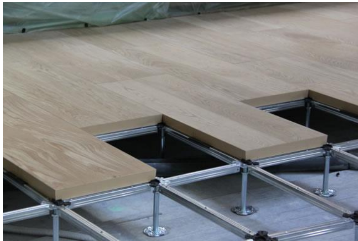
Figura 1 – Detalle de suelo técnico
