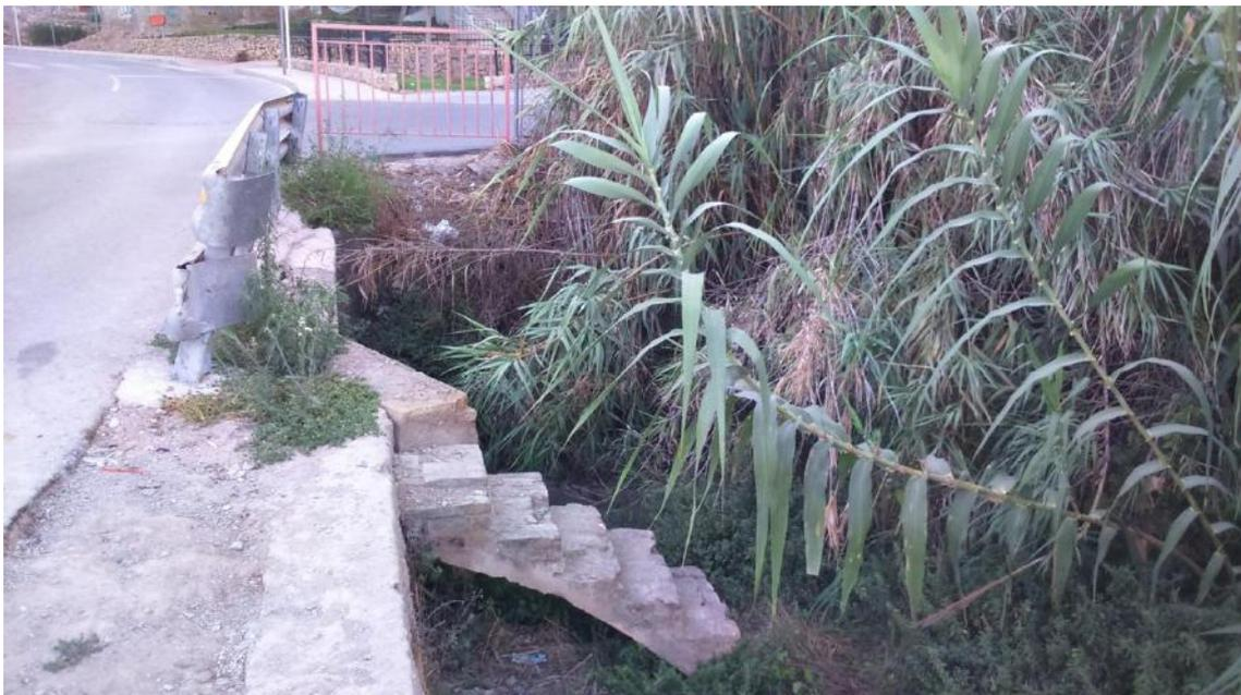
**Foto 3.2.: Escaleras de hormigón que serán demolidas**
