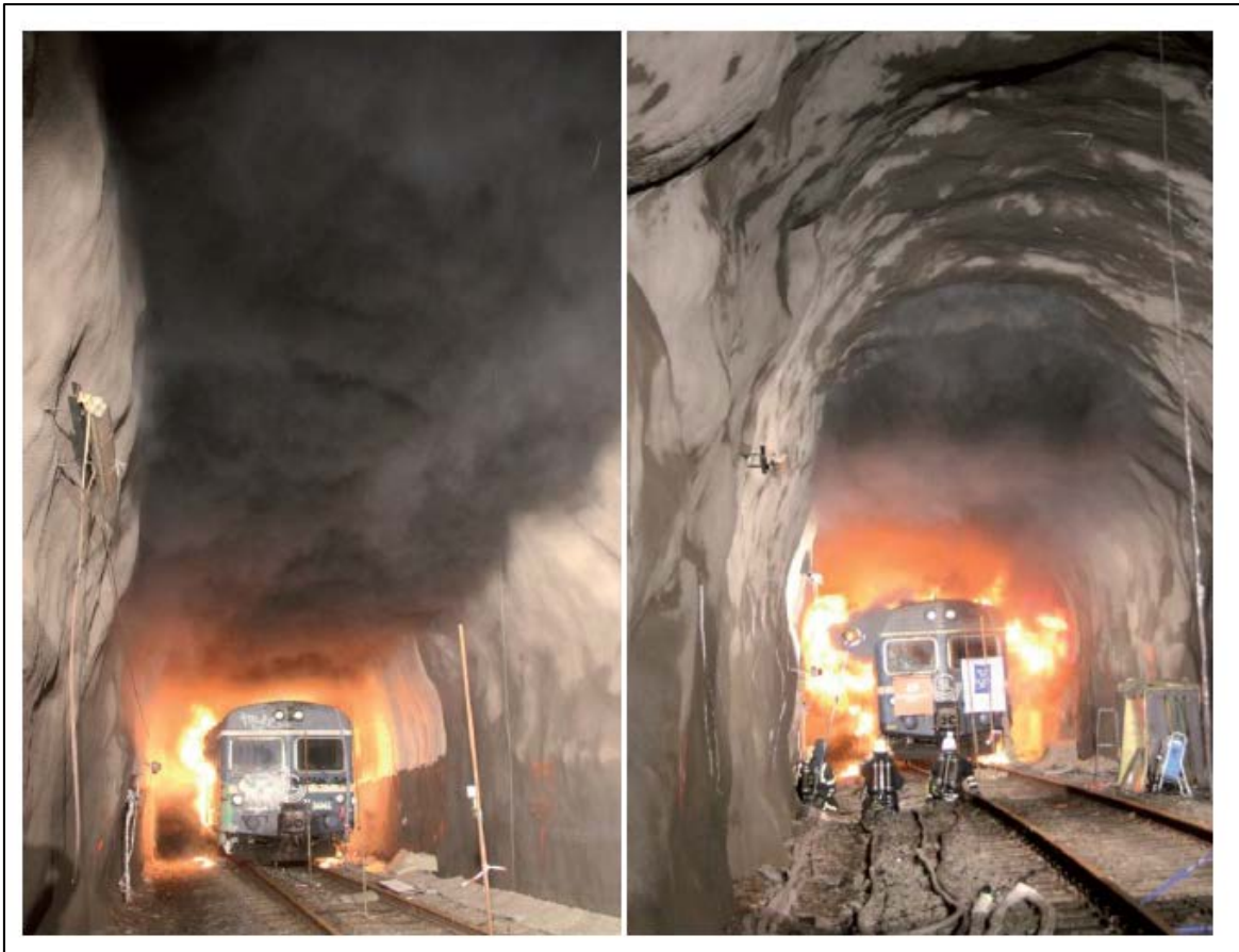
Figura 64. Izq. Retropropagación desarrollada en test 2. Dcha. Inicio del proceso de la retropropagación de los humos en el test 3
