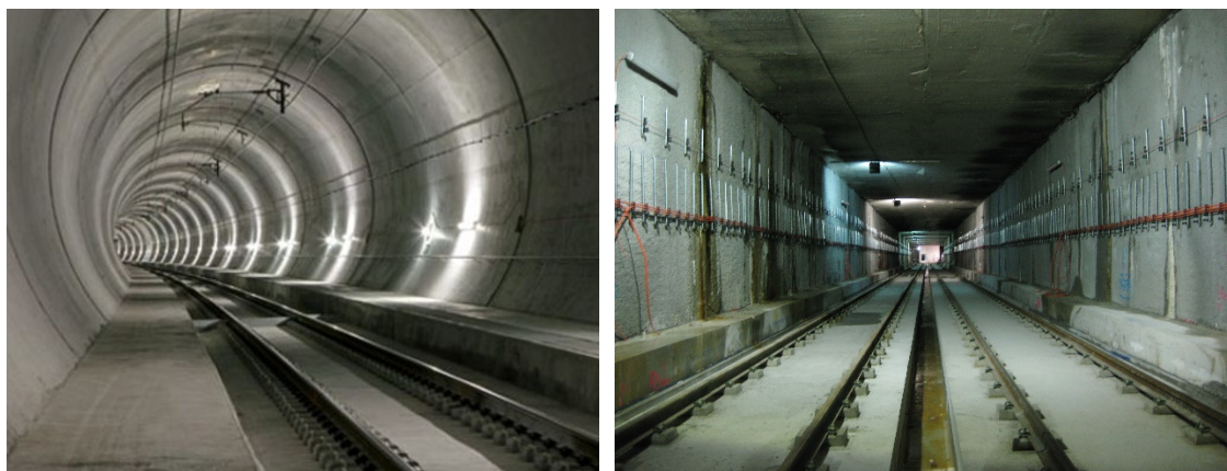
Figura 39. Aceras de evacuación en túneles ferroviarios.
