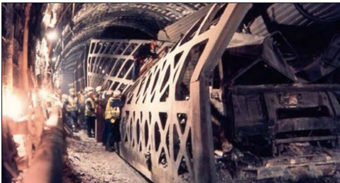
Figura 2 . Restos del incendio en el túnel del Canal
