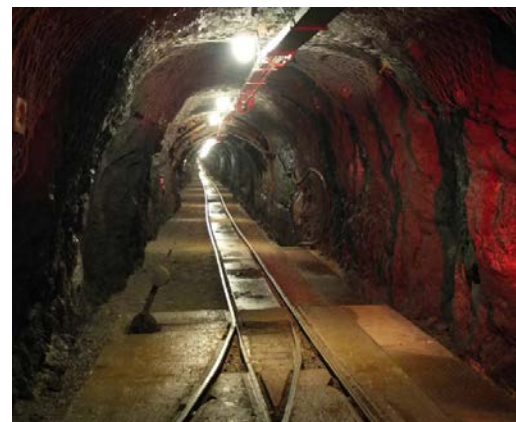
Figura 17. Túnel con rail para mina.
