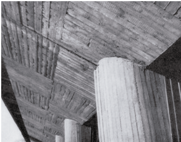
Imagen 30: Detalle de la textura de los pilotis.
