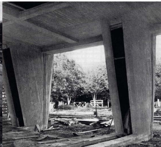
Imagen 71: Pilotis desencofrados.
