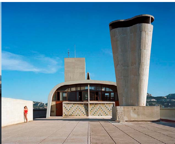
Imagen 52: Gimnasio, chimenea de ventilación y torre.
