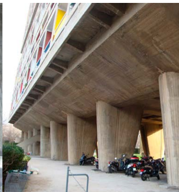
Imagen 43: Vista inferior planta técnica.
