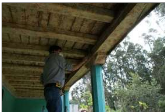
Imagen 3.16.- Proceso de limpieza y toma de datos Fuente: Propia
