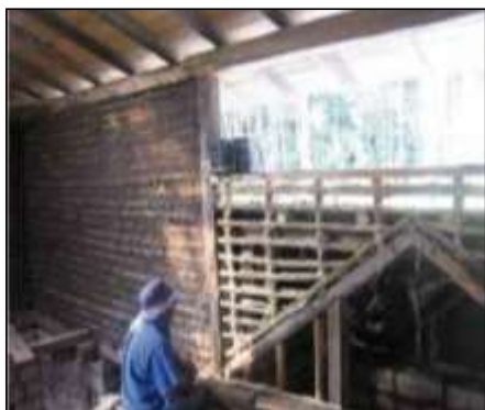
Imagen 11.- Detalle de armado de bahareque.
