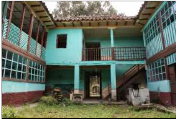
Imagen 3.6.- Vista patio central Fuente: Propia
