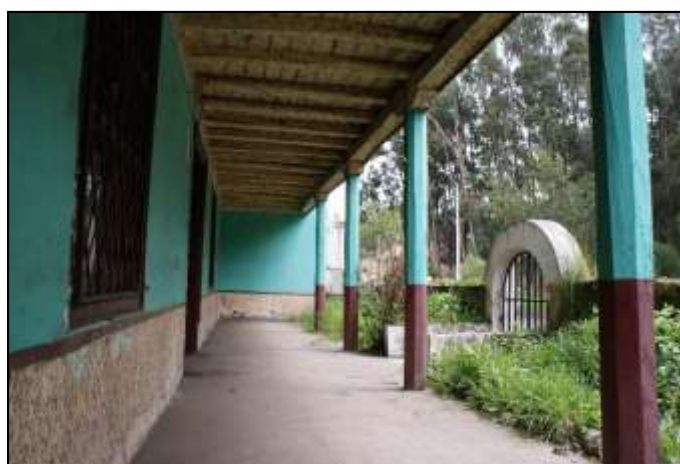
Imagen 3.5.- Vista porche de entrada Fuente: Propia
