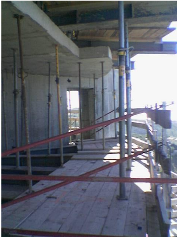
Ilustración 97 Plataforma de apoyo Mesas dos niveles inferiores.2006.Raúl López
