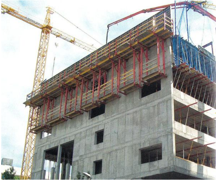
Ilustración 14 Consola trepante.2008.Alsina
