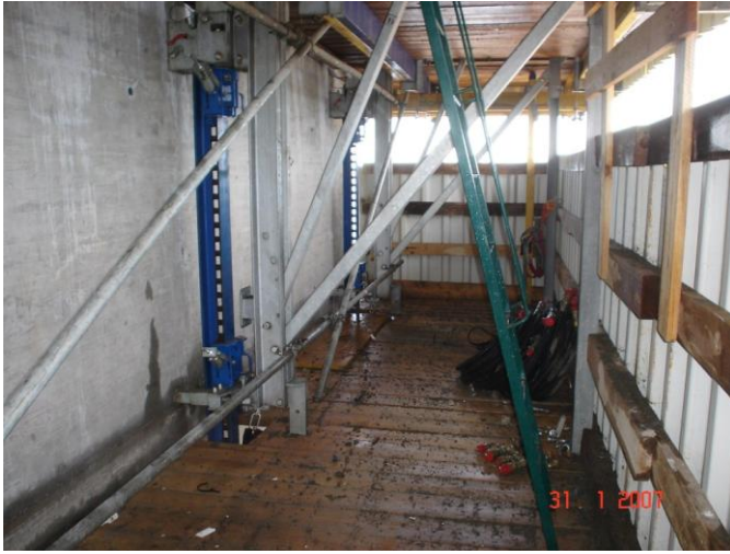
Ilustración 40 Plataforma de trepado.2006. Torre Lugano
