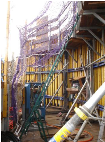
Ilustración 39 Plataforma de trabajo Autotrepa.2006. Raúl López
