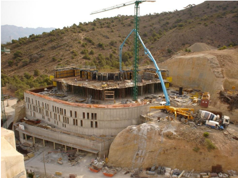
Ilustración 50 Hormigonado primer forjado.2006.Raúl López
