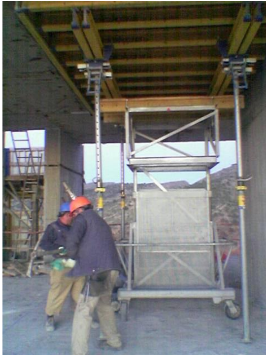
Ilustración 85 Sacado de Mesas hasta el borde del forjado.2006.Raúl López
