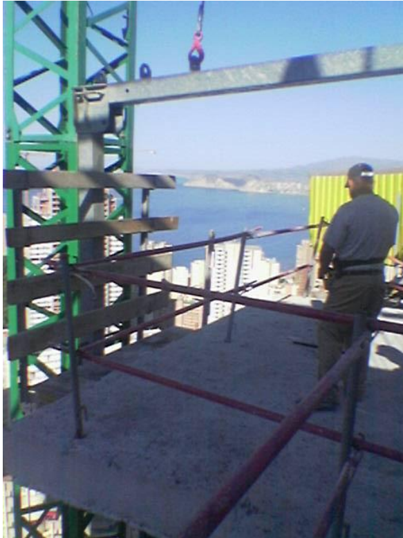
Ilustración 86 Enganche de la Mesa con la Horquilla.2006.Raúl López
