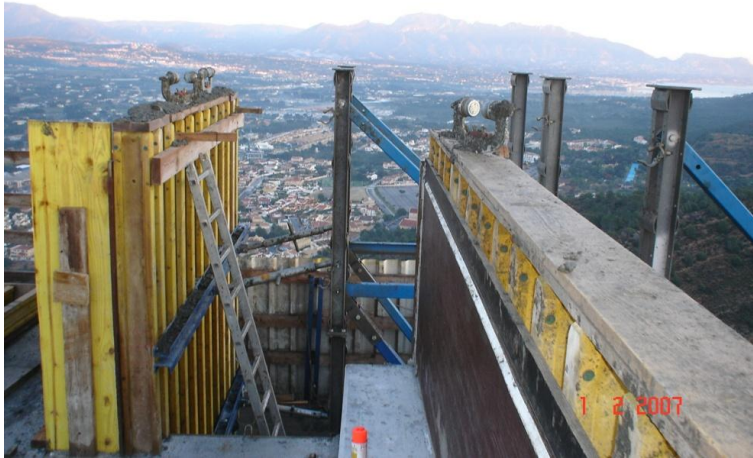
Ilustración 43 Berenjeno de plástico colocado en el encofrado.2016.Raúl López
