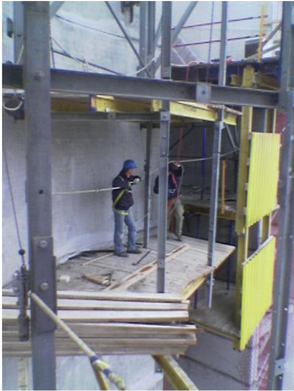
Ilustración 61 Proceso desmontaje Autotrepas.2007.Raúl López
