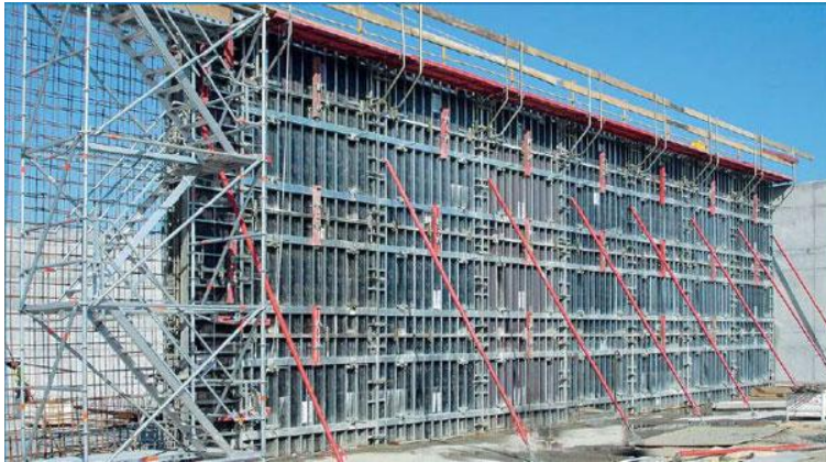
Ilustración 10 Encofrado metálico de muro.2008.Alsina
