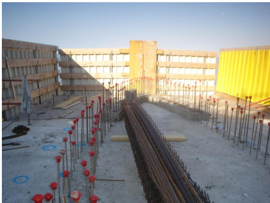
Ilustración 99 Encofrado de Mesas para ejecución de la Vela.2006.Raúl López
