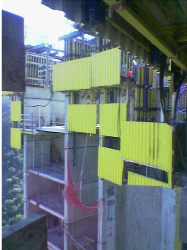
Ilustración 59 Fase de trepado planta técnica nº 41.2006.Raúl López
