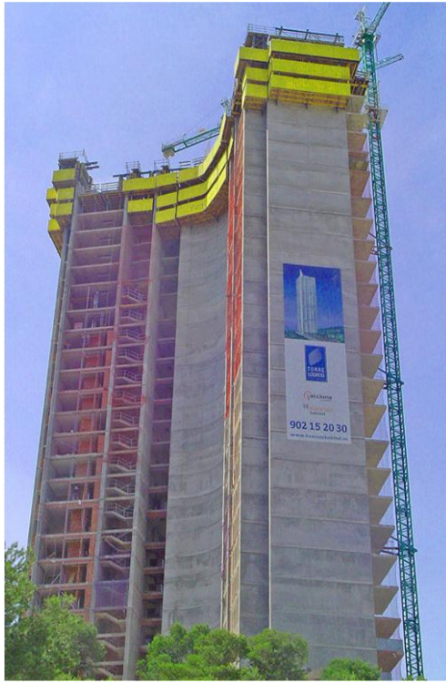
Ilustración 15 Estructura realizada con Autotrepa, Torre Lugano.2006.Raúl López
