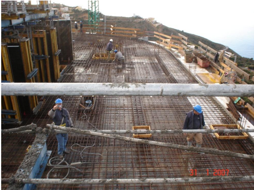
Ilustración 92 Forjado planta técnica previo al hormigonado.2007.Raúl López
