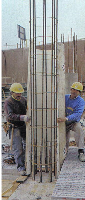
Ilustración 6 Encofrado pilar redondo de fibra de vidrio.2008.Alsina
