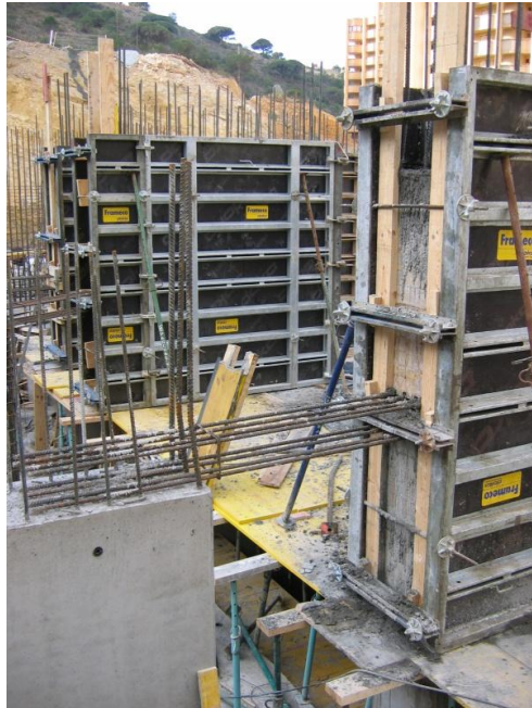
Ilustración 34 Encofrado pantallas interiores.2005.Raúl López
