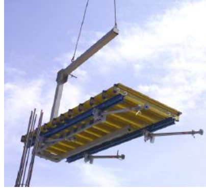
Ilustración 83 Horquilla de desplazamiento con grúa.2016.Doka
