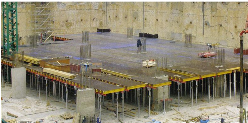
Ilustración 24 Encofrado de Mesas.2008.Alsina
