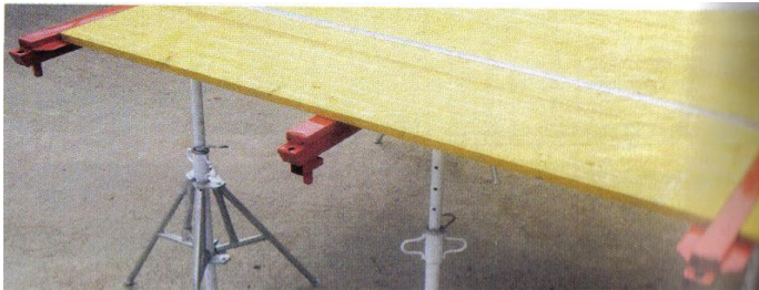
Ilustración 20 Apoyo tablero en portasopanda.2008.Alsina
