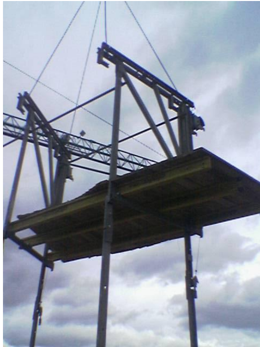
Ilustración 62 Bajada de parte del Autotrepa con la ayuda de la grúa torre.2007.Raúl López
