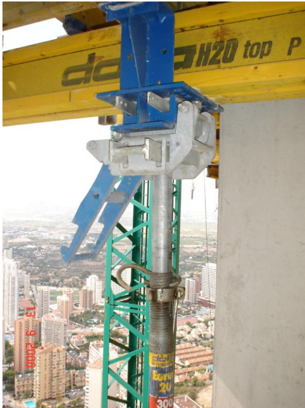
Ilustración 79 Cabezal y puntal telescópico de la Mesa de encofrado.2006.Raúl López
