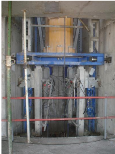
Ilustración 65 Conexión del distribuidor de hormigón al Autotrepa.2006.Raúl López
