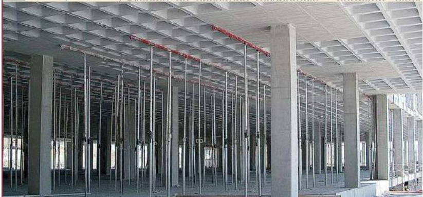
Ilustración 17 Vista inferior una vez recuperado el encofrado reticular.2008.Alsina
