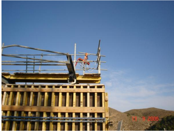
Ilustración 38 Plataforma de llenado hormigón Autotrepa.2006.Raúl López
