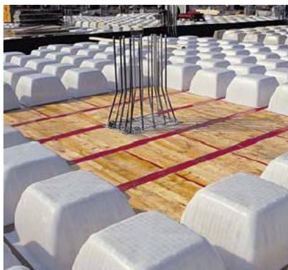
Ilustración 16 Encofrado para forjado reticular.2008.Alsina
