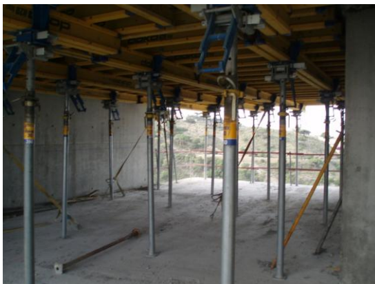
Ilustración 93 Planta con Mesas previo a su desencofrado.2006.Raúl López
