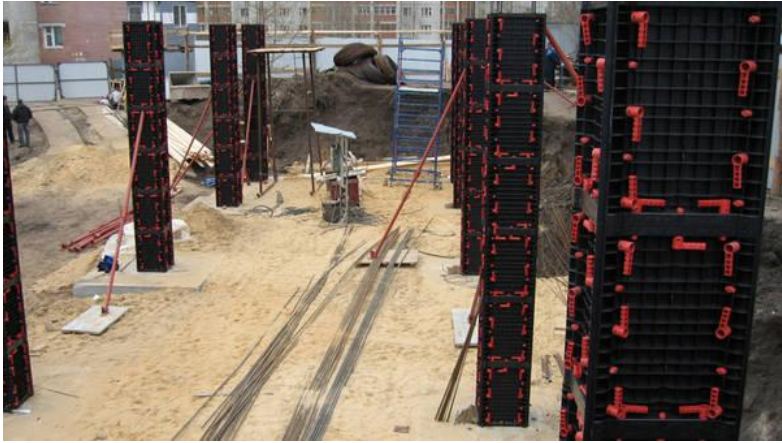
Ilustración 8 Encofrado de pilares de plástico.2016.Clarin
