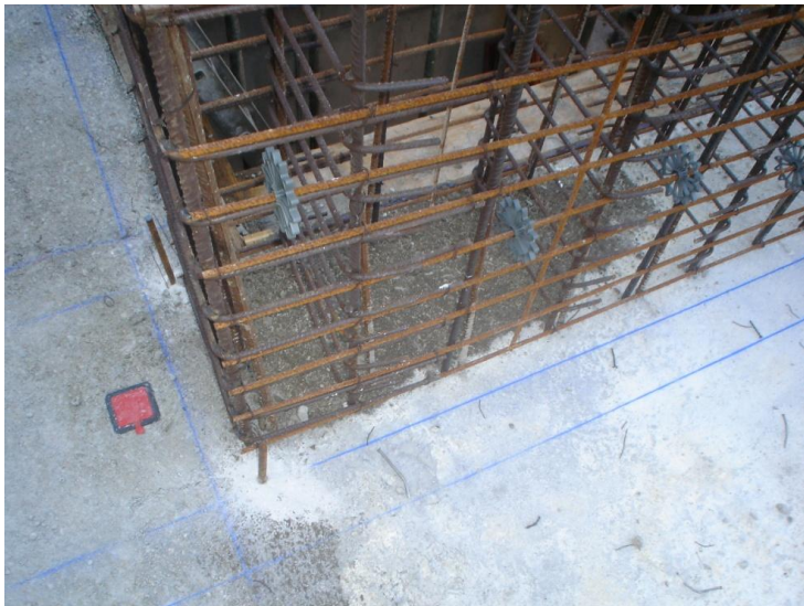
Ilustración 72 Replanteo pantalla interior.2006.Raúl López
