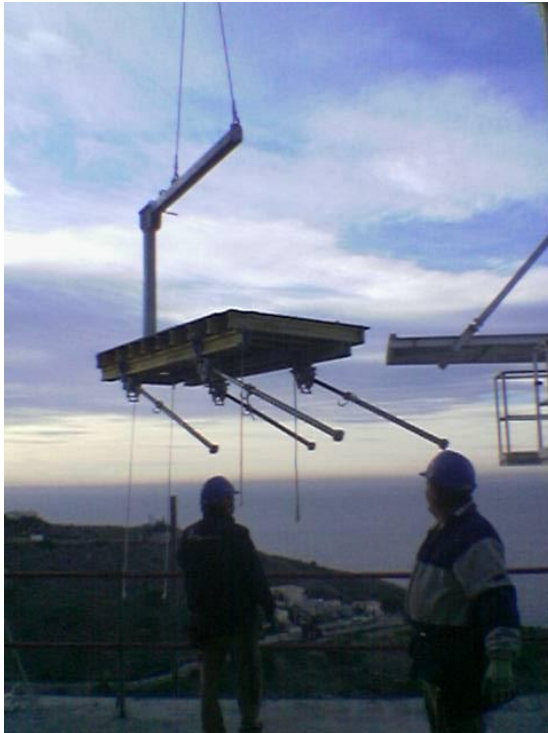
Ilustración 87 Traslado de la Mesa hasta el forjado superior.2006.Raúl López
