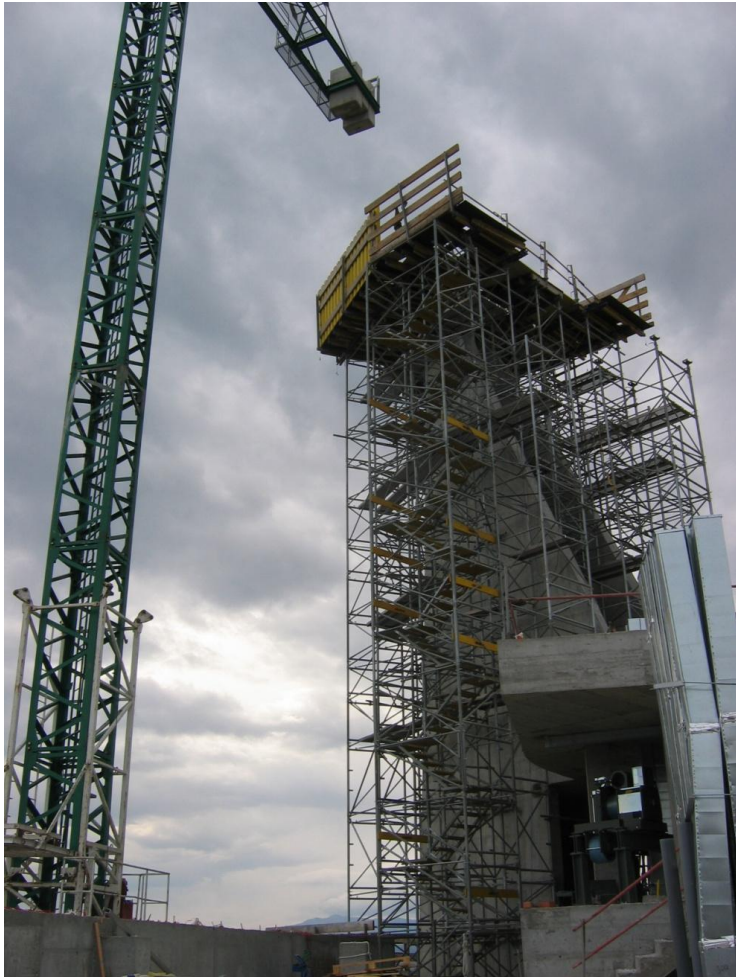
Ilustración 100 Encofrado de Mesas con soportes cimbra para ejecución del pico de la vela.2007.Raúl López
