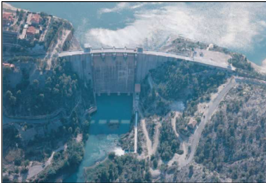
Figura 10.1: Vista aérea general de la presa y del entorno de la cerrada (Fuente: Membrillera [92])
