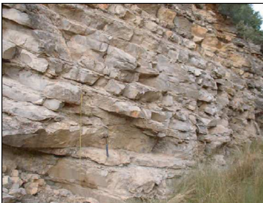
Figura 10.4: Detalle del macizo rocoso en el estribo derecho: buzamiento aparente de los paquetes calizos y margosos (Fuente: Membrillera [92]).
