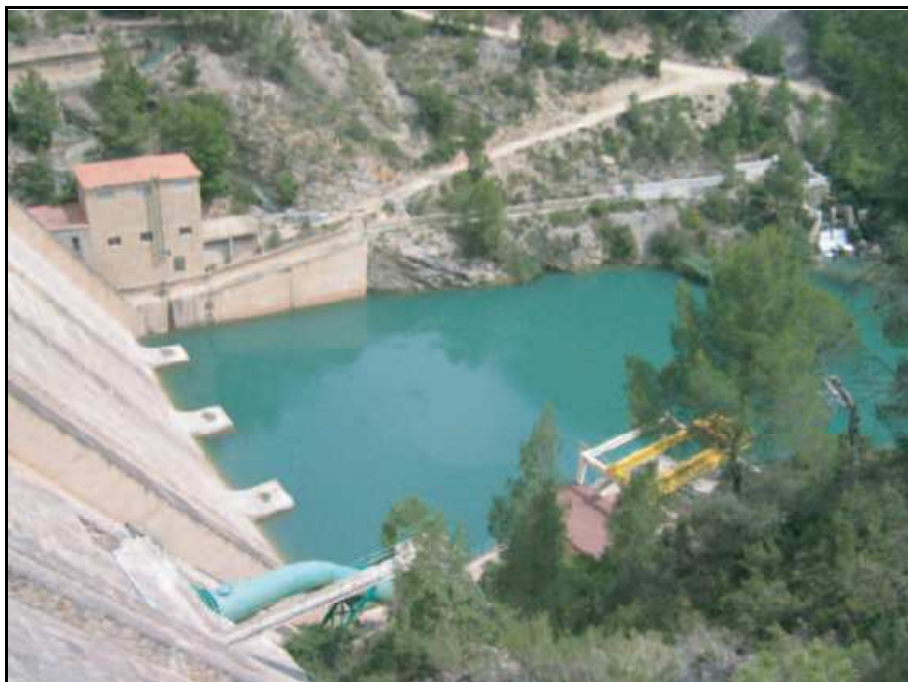
Figura 10.2: Vista del paramento aguas abajo y del pie en el estribo izquierdo
