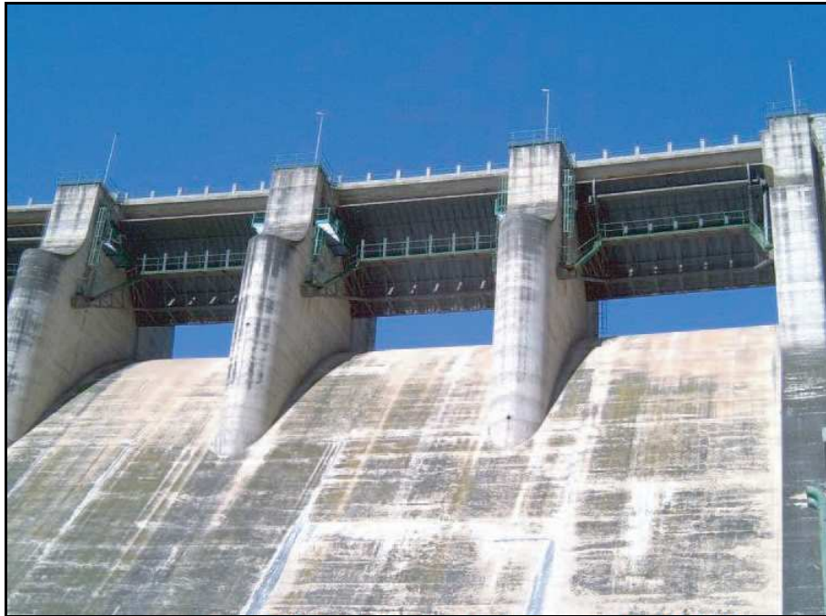
Figura 10.3: Aliviadero superficial de la presa desde aguas abajo (Fuente: Membrillera [92])
