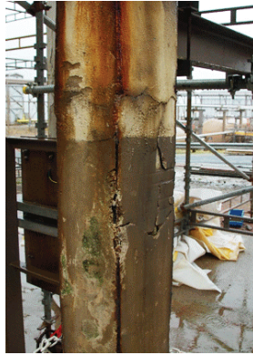
Ilustración 2. Cambio de color del revestimiento ignífugo.
