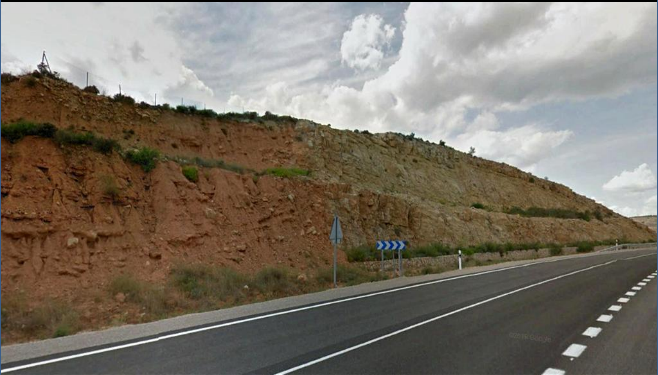
Contacto – por falla-de las areniscas, argilitas y arcillas del Mioceno, Terciario, con las calizas del Cenomaniense, Cretácico Sup. SE de Castielfabib, Valencia. NE Hoja de Ademuz.
