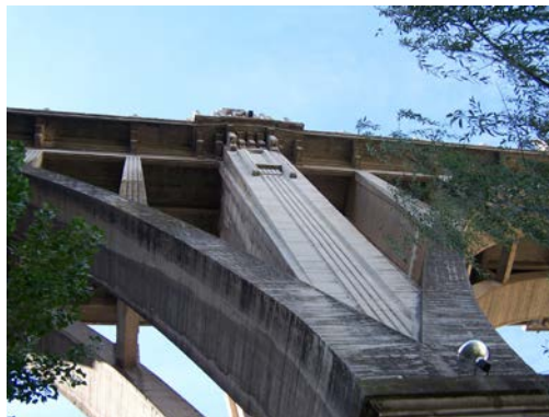
Figura 2. Vista de una pilastra del Puente de San Jorge
