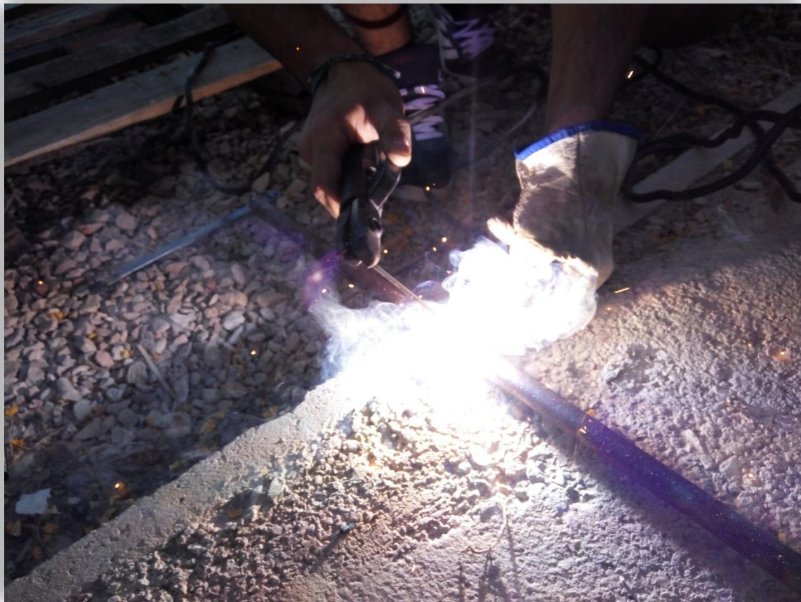
Fig. 30 Soldadura MIG de la pletina.
