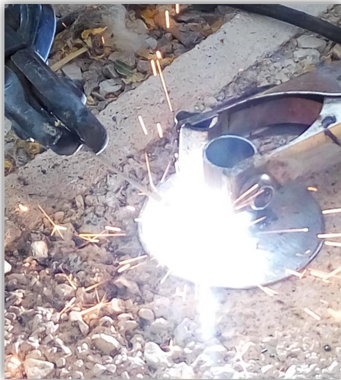
Fig. 38 Soldadura MIG de las dos piezas.
