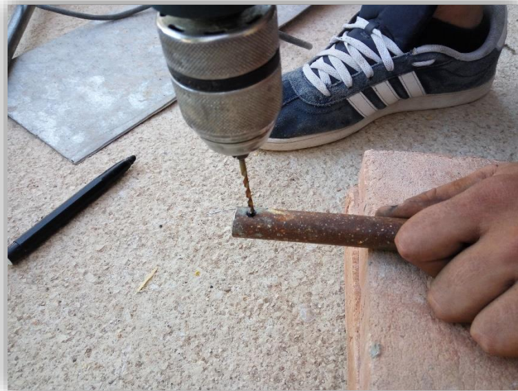
Fig. 34 Primera perforación con broca fina.
