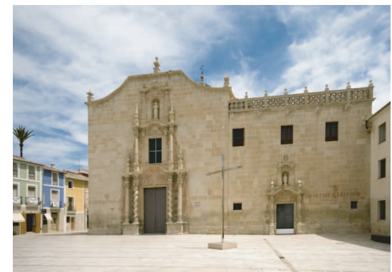
Fig 17. Entorno del monasterio de la Santa Faz, Alicante, después de la intervención de 2006.
