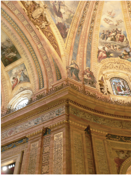
Fig 45. S. Francisco el Grande. Encuentro alzado interior, cúpula y bóveda.
