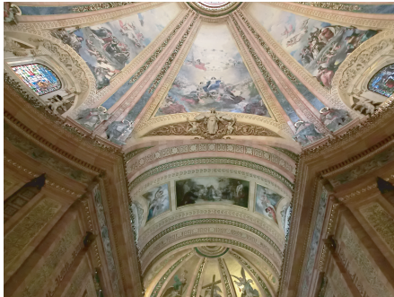
Fig 46. S. Francisco el Grande. Encuentro cúpula y bóveda de cañón.
