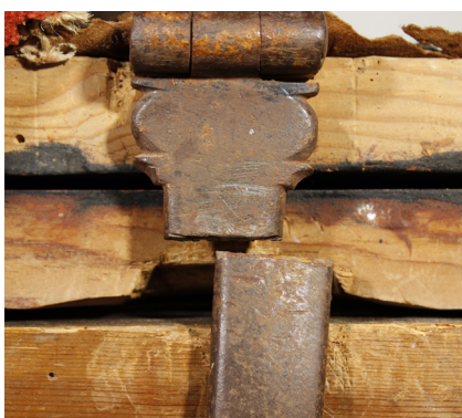
89. Detalle del corte de una de las fallebas.
