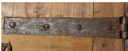
42. Detalle de bisagra de pala larga en una de las alas abatibles.
