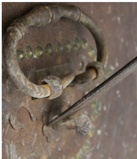
46. Detalle del apoyo del fiador con el asa.
