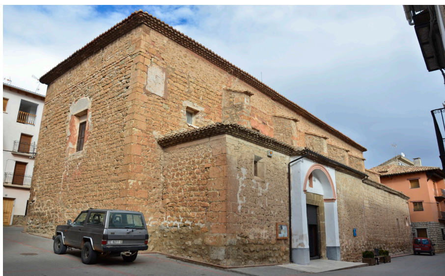
Figura 3. Vista exterior de la iglesia parroquial.
