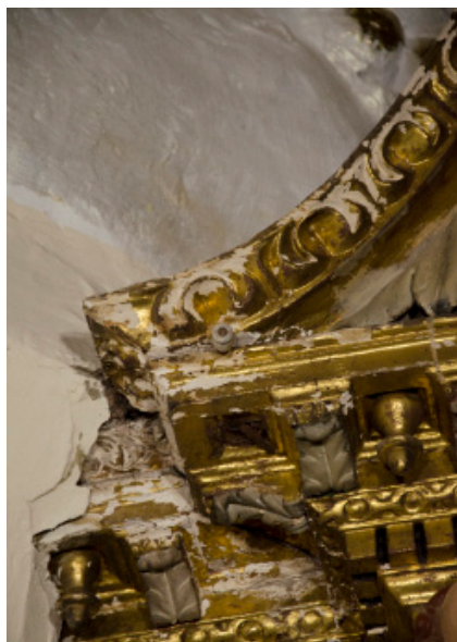
Figura 27. Detalle del asentamiento directo de la yesería sobre la mazonería.
