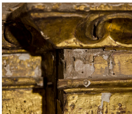
Figura 42. Detalle de desprendimiento del estrato metálico.
