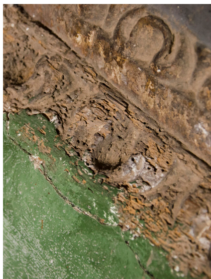
Figura 31. Detalle de la zona del zócalo.
