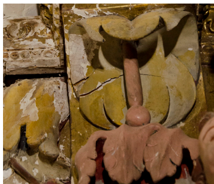
Figura 36. Detalle de agrietamiento puntual en la mazonería.
