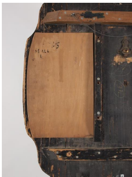
Fig. 24 Zona izquierda del reverso de la obra en el que se puede ver la pieza de madera adherida como nuevo sistema de refuerzo.
