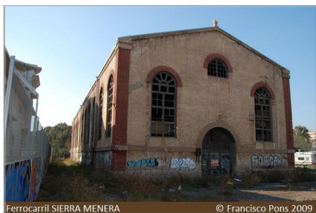
Figura 7: Nave de efectos y repuestos antes de la restauración.
