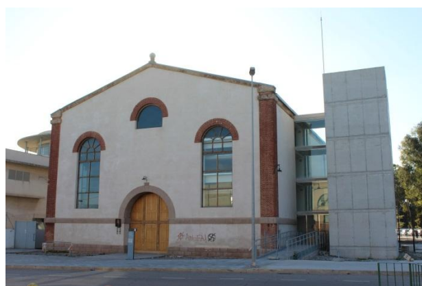
Figura 8: Nave de efectos y repuestos en la actualidad.
