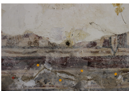
Fig.-24 intervención indicadores de inyección
