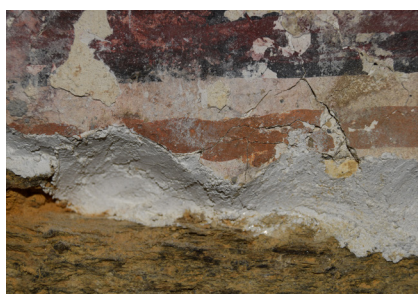
Fig.-25 Intervención mortero perimetral
