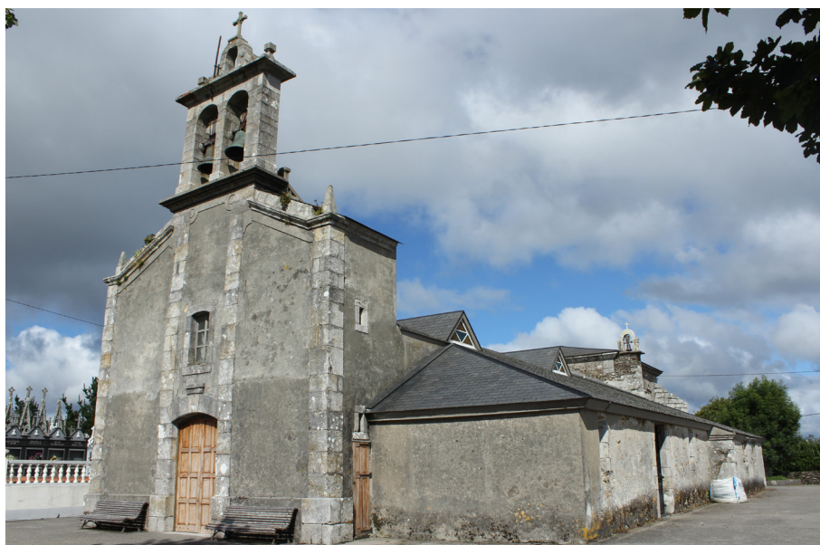
Fig.-3. Entorno del edificio
