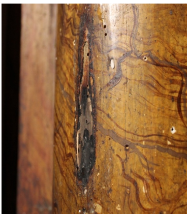
Figura 32. Detalle de quemadura en la columna.
