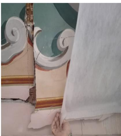
Figuras 32, 33 y 34. Protección de la pintura previo arranque.
