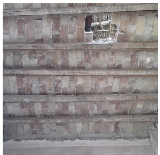
Figura 39. Extracción total de la pintura.
