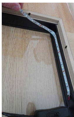
img.36. instalación del sistema de leeds
