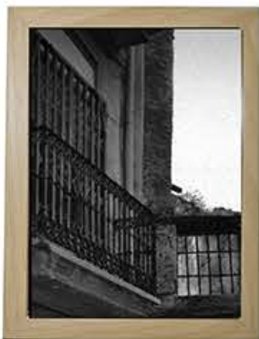
img.47. Fincas en deterioro.
