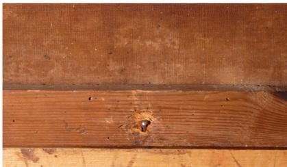
**Imagen 30.** Detalle del clavo forjado sujetando el bastidor al marco.
