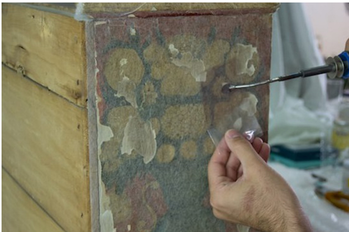
Imagen 29. Consolidación y refuerzo, asentamiento de cazoletas con espátula caliente.
