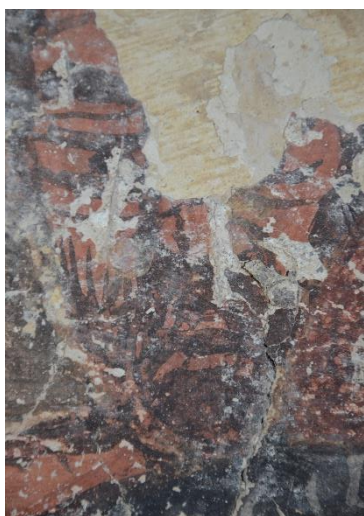
Fig.- 26. Detalle de fisuras en el Juicio Final.
