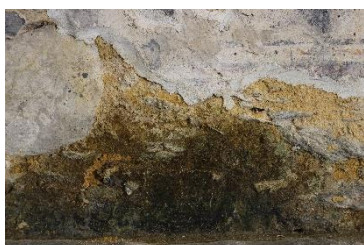
Fig.- 31. Ejemplo de biodeterioro en el interior del inmueble.
