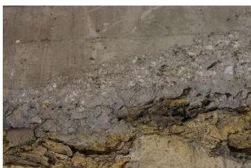
Fig.- 23. Parte superior del muro con la nueva construcción de cemento y parte inferior con las bancadas.
