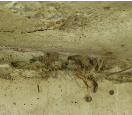
Figura 17. Detalle de depósitos orgánicos.
