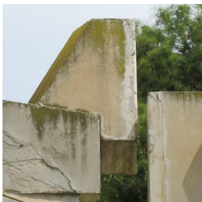
Figura 27. Detalle de ataque biológico. II
