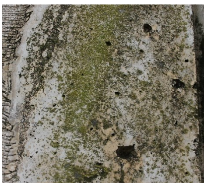
Figura 28. Detalle de ataque biológico. III
