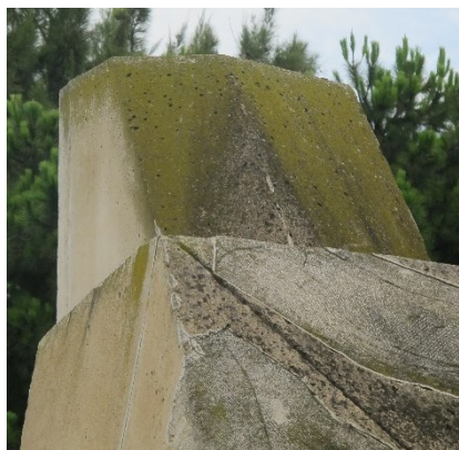
Figura 26. Detalle de ataque biológico.
