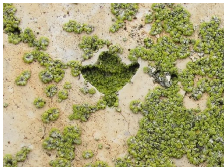
Figura 25. Depósito biológico en un orificio de la pieza
