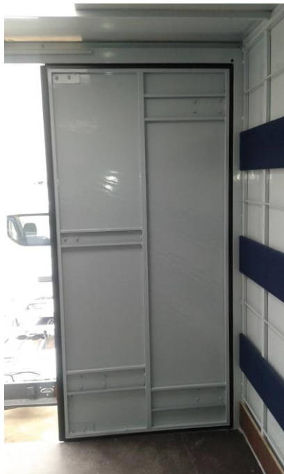
Imagen de la puerta cerrada y su estructura
