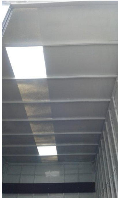
Vista de detalle del techo de la caja
