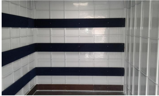
Vista de detalle de la estructura de las paredes
