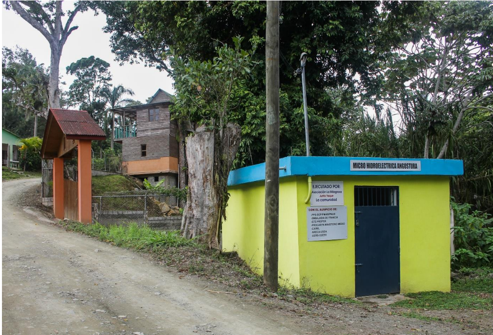
Fotografía 1. Casa de máquinas de la microhidroeléctrica de Angostura
