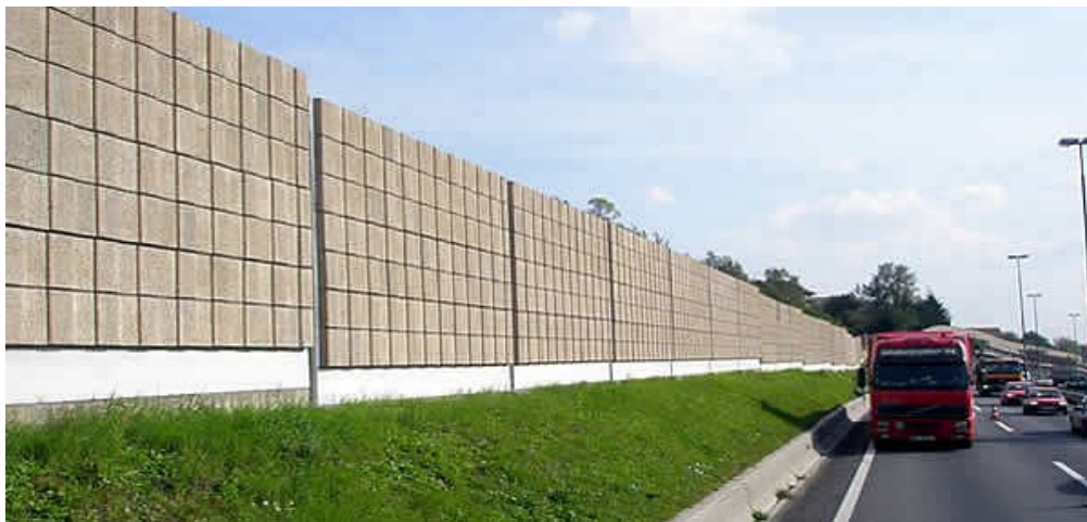
Figura 4. Pantalla acústica de hormigón, tipo absorbente con una altura h = 3 m y un espesor e = 0.17 m.
