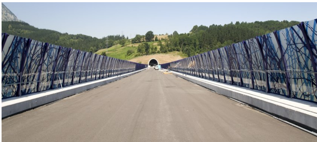
Figura 5. Pantalla acústica de metacrilato, tipo reflectante con una altura h = 3 m.
