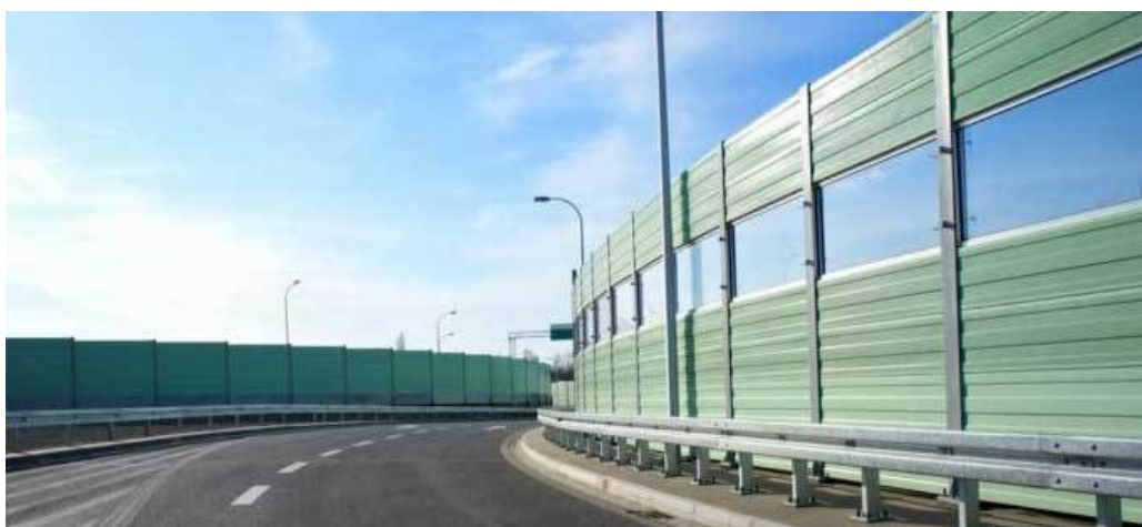
Figura 6. Pantalla acústica mixta: metacrilato-metal perforado, con una altura h = 3 m.
