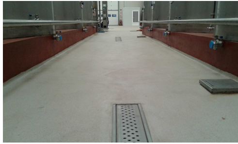
Fig.52. Suelo zona depósitos bodega.
