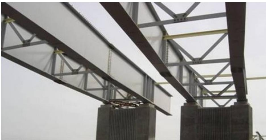
Figura 6.1: Vigas armadas empleadas en la construcción de un puente [24]. Ejemplo de aplicación en el campo de la construcción.
