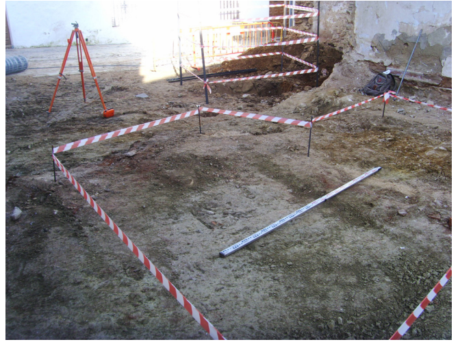
FOTO 2. CALLE TORREJONES, 30, PERIMETRO DE TERRENO A EXCAVAR
