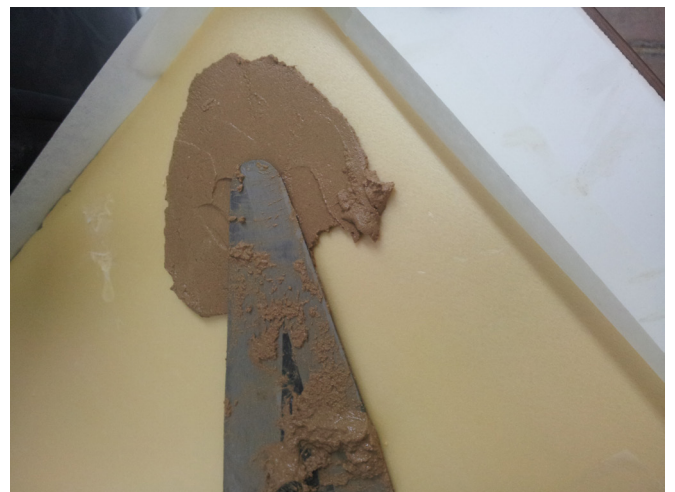
FOTO 199. APLICACIÓN DEL MORTERO A LAS PLANCHAS DE POLIESTIRENO EXTRUIDO
