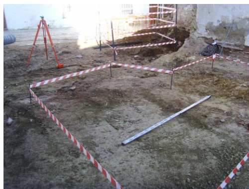
Figura 1. Fotografía de la excavación
