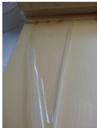
FOTO 205. APLICACIÓN DE TIRANTES DE CINTA ADHESIVA
