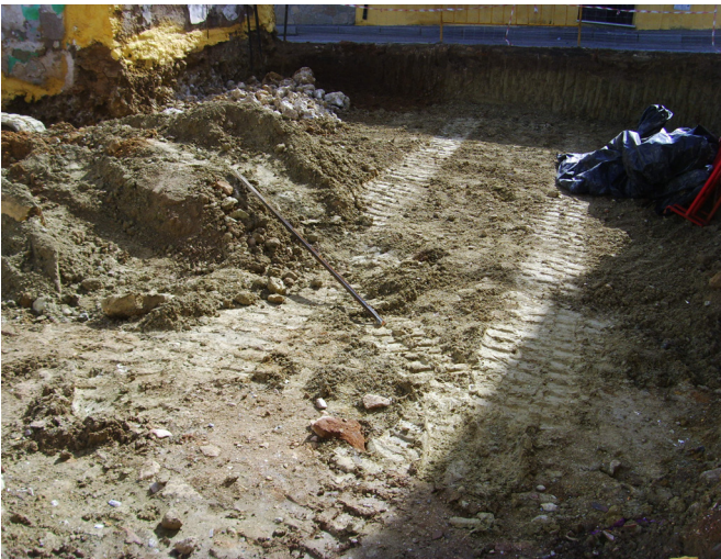
FOTO 3. PROCESO DE EXCAVACIÓN FASE I
