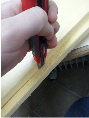
FOTO 194. ELIMINACIÓN DE LAS JUNTAS
