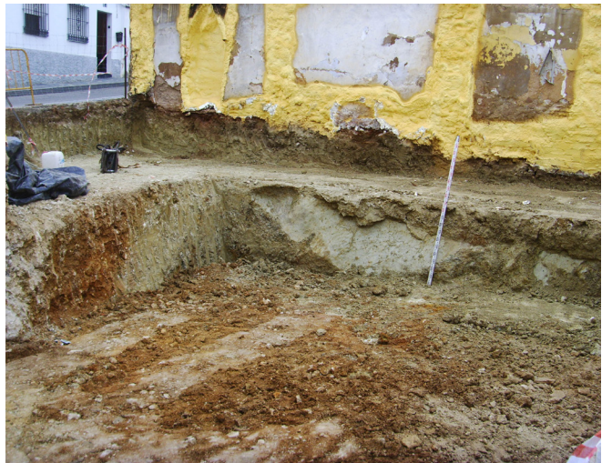
FOTO 4. PROCESO DE EXCAVACIÓN FASE II
