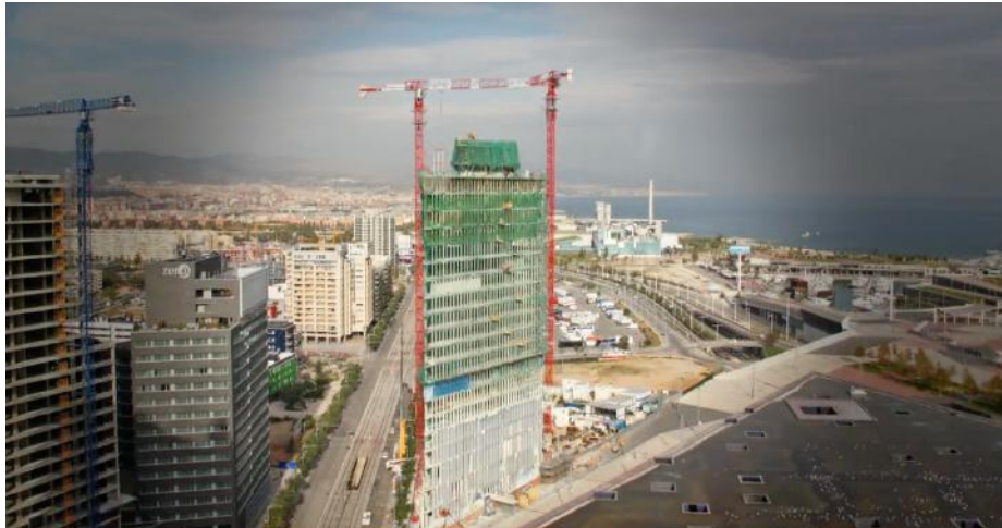
Imagen 3.2.4. Montaje muro cortina y "bambúes" de la fachada
