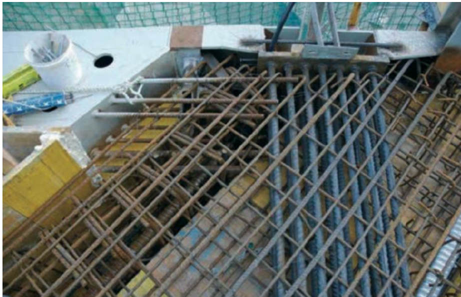
Imagen 3.1.13. Encuentro viga de patio, viga descolgada y cajetín
