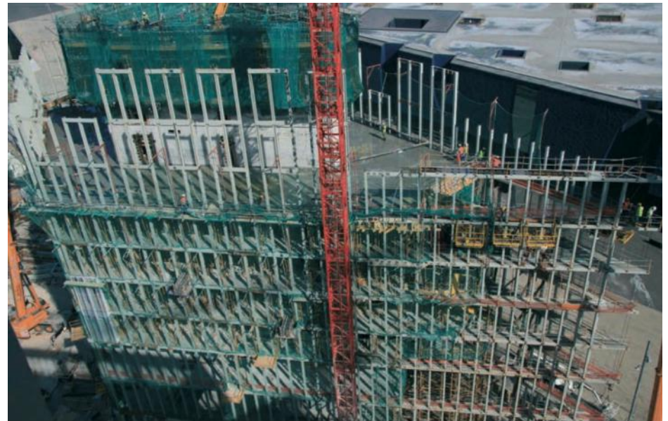
Imagen 3.1.5. Proceso constructivo soportes
