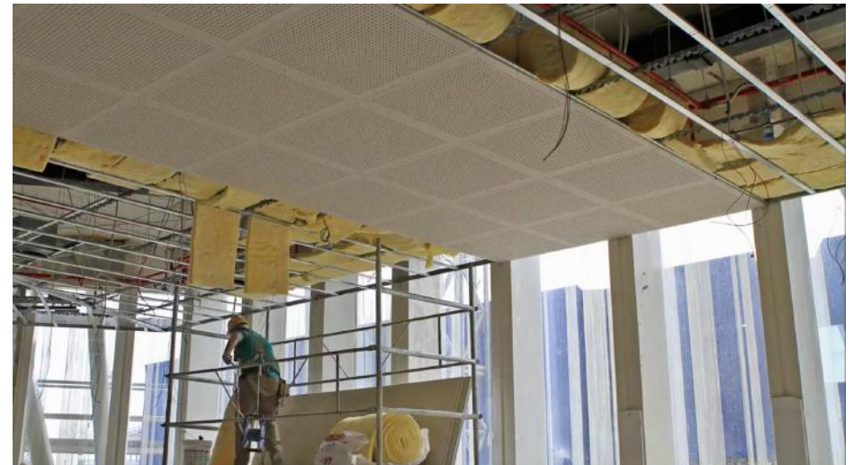
Imagen 3.2.13. Montaje del falso techo
