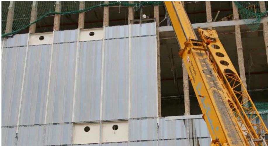
Imagen 3.2.8. Montaje del muro cortina
