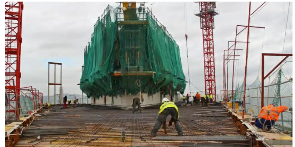
Imagen 3.2.7. Detalle puesta en obra del núcleo central
