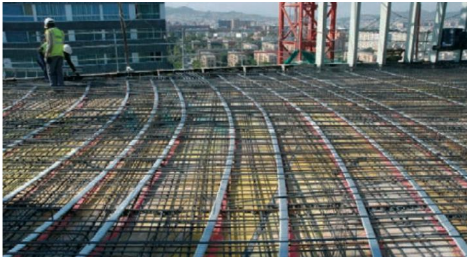
Imagen 3.1.17. Cables losas de forjado
