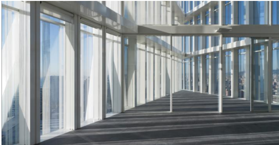
Imagen 4.1.7. Imagen interior vigas de patio y soportes interiores metálicos II
