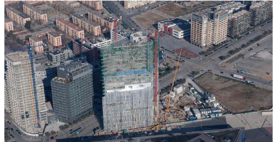
Imagen 3.1.2. Proceso constructivo de la torre I
