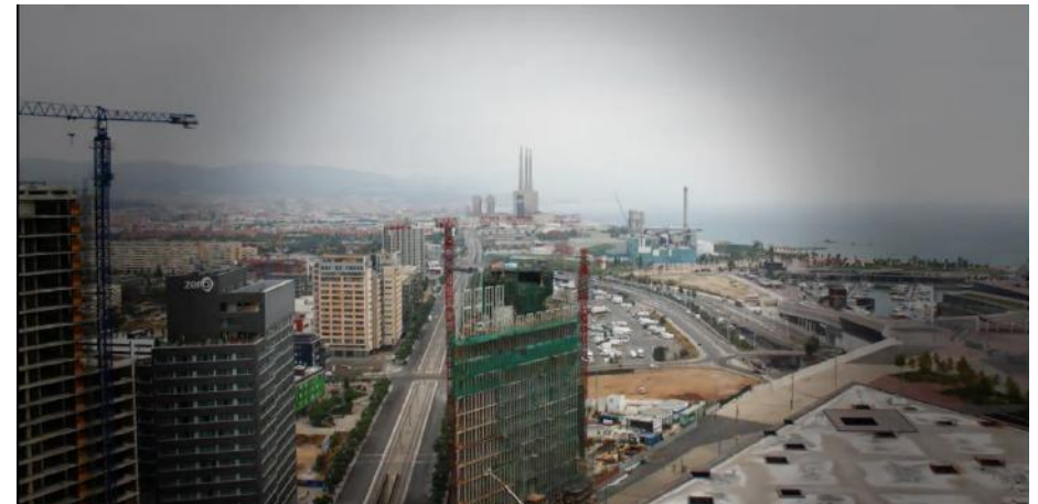
Imagen 3.2.2. Montaje y soldado de los soportes metálicos
