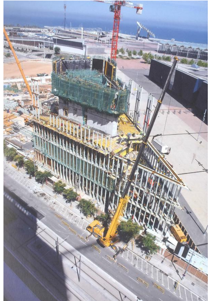
Imagen 3.1.4. Proceso constructivo de la torre II
