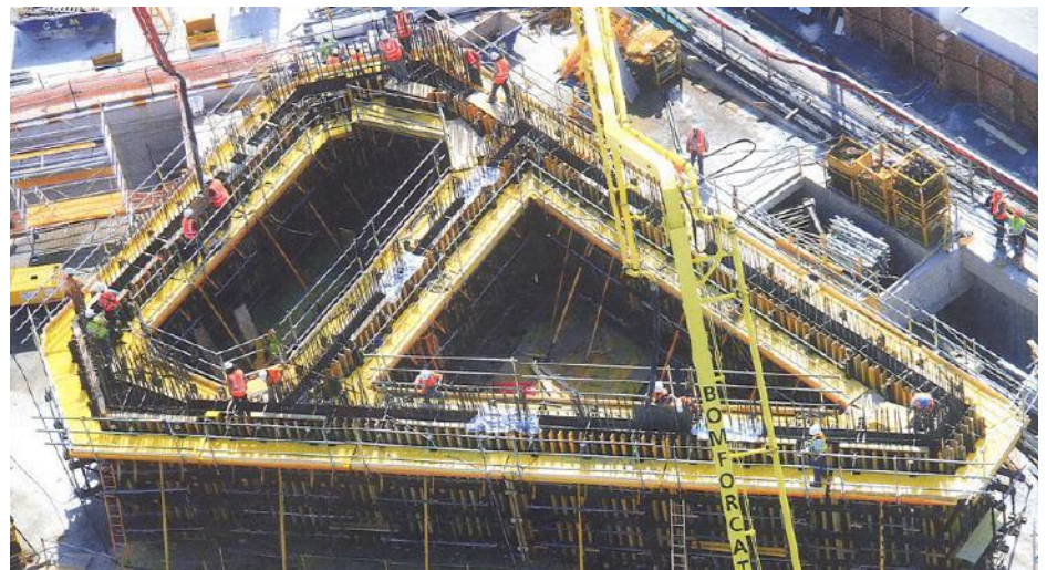
Imagen 2.4.1. Núcleo central de hormigón
