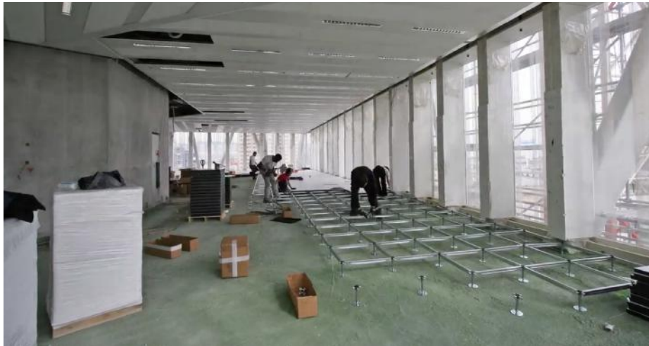
Imagen 3.2.11. Soportes recubiertos con el cajón metálico blanco
