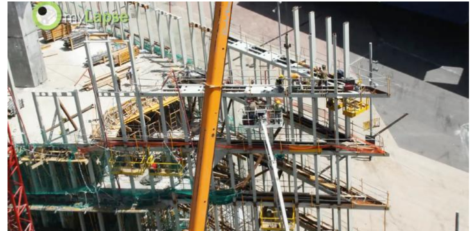
Imagen 3.2.6. Montaje de las vigas de patio
