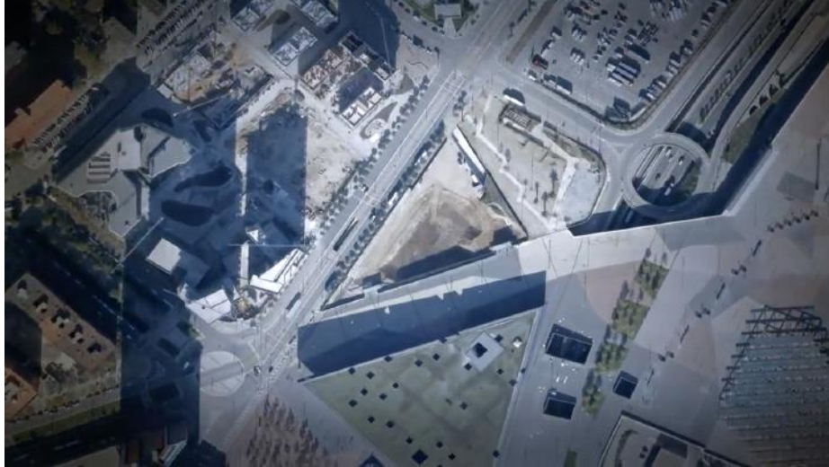
Imagen 3.2.1. Emplazamiento con excavación
