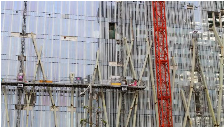
Imagen 3.2.12. Montaje de los "bamboos" de la fachada
