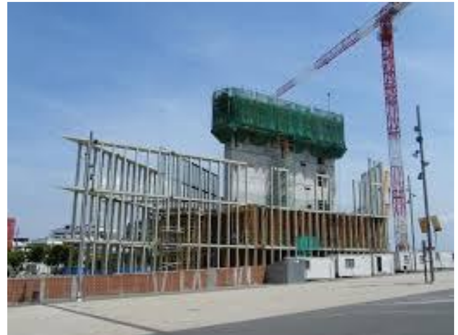
Imagen 4.1.4. Imagen del núcleo interior de hormigón
