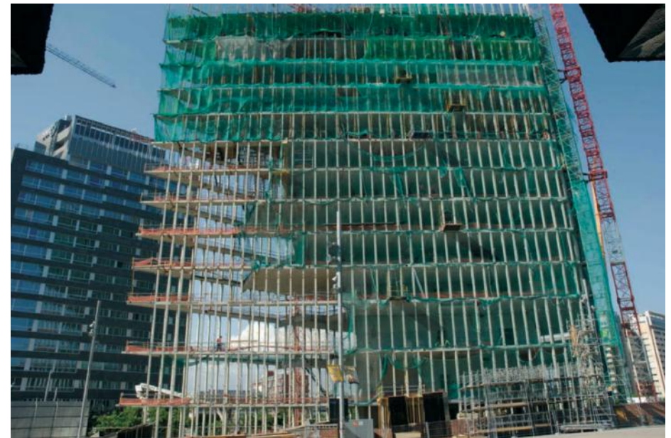
Imagen 3.1.7. Proceso constructivo vigas y soportes
