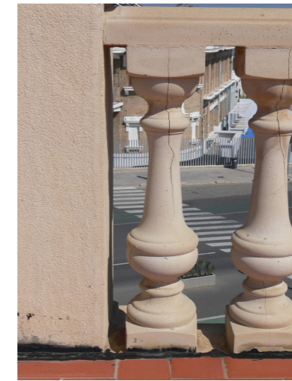
BALAUSTRES DE LA AZOTEA
