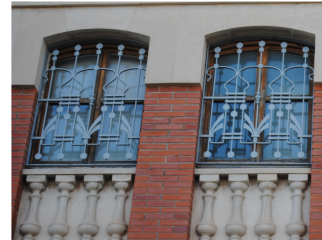
CARPINTERÍAS CON REJAS METÁLICAS EN LA PRIMERA PLANTA
