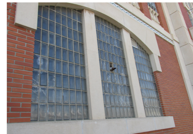
CARPINTERÍA DE PAVÉS EN LA PLANTA BAJA
