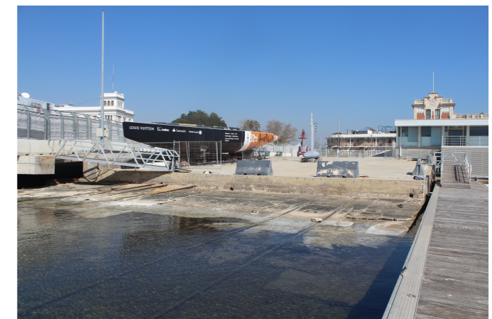
RAMPA DEL VARADERO ADJUNTA AL EDIFICIO
