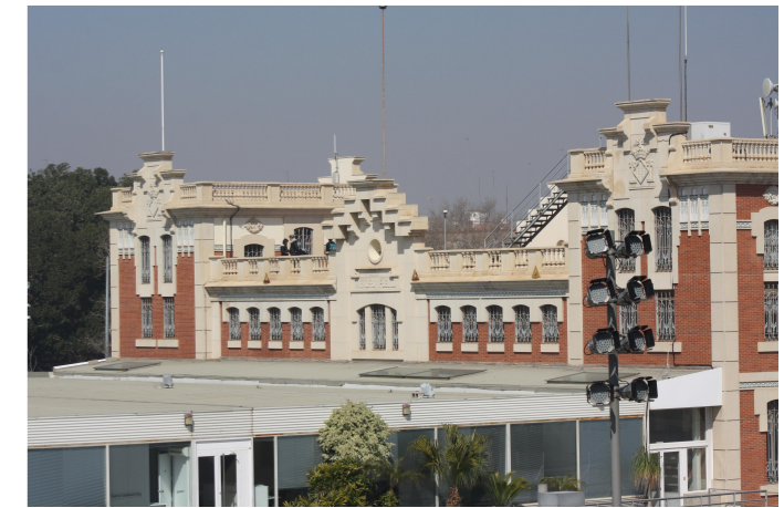
VISTA POSTERIOR DEL VARADERO - INSTALACIONES PROVISIONALES
