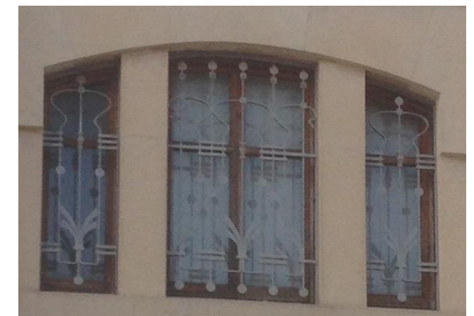
CARPINTERÍAS QUE FORMAN UN ARCO REBAJADO
