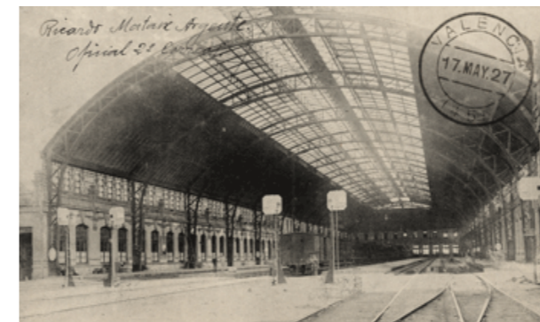
HANGAR (MARQUESINA METÁLICA)
