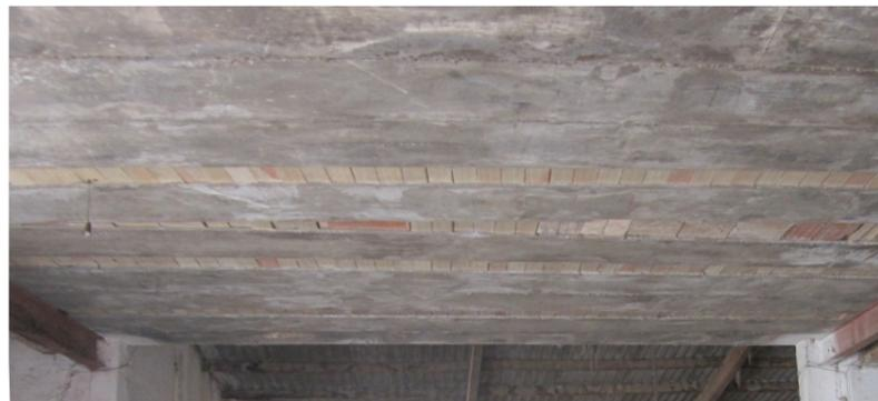
EA 3.4. Forjado unidireccional conformado con viguetas cerámicas y bovedillas de yeso. Fuente propia.
