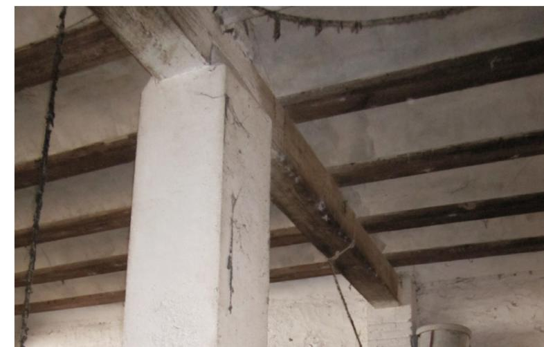
EA 3.3. Forjado unidireccional con vigas de madera resuelto a revoltones. Fuente propia.
