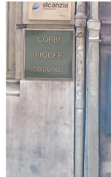
Imagen 267. Bajante pluvial de fundición.
