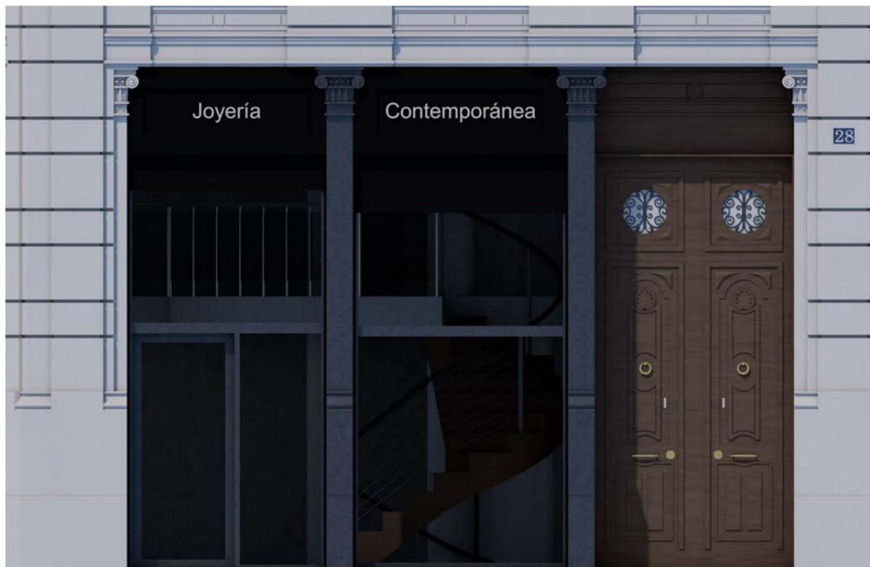
Imagen 332. Pilares de fundición en fachada. Render.
