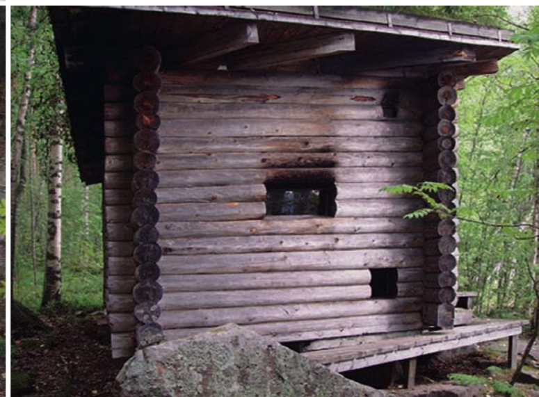
Imagen 34. Detalle de la cimentación sobre la roca.
