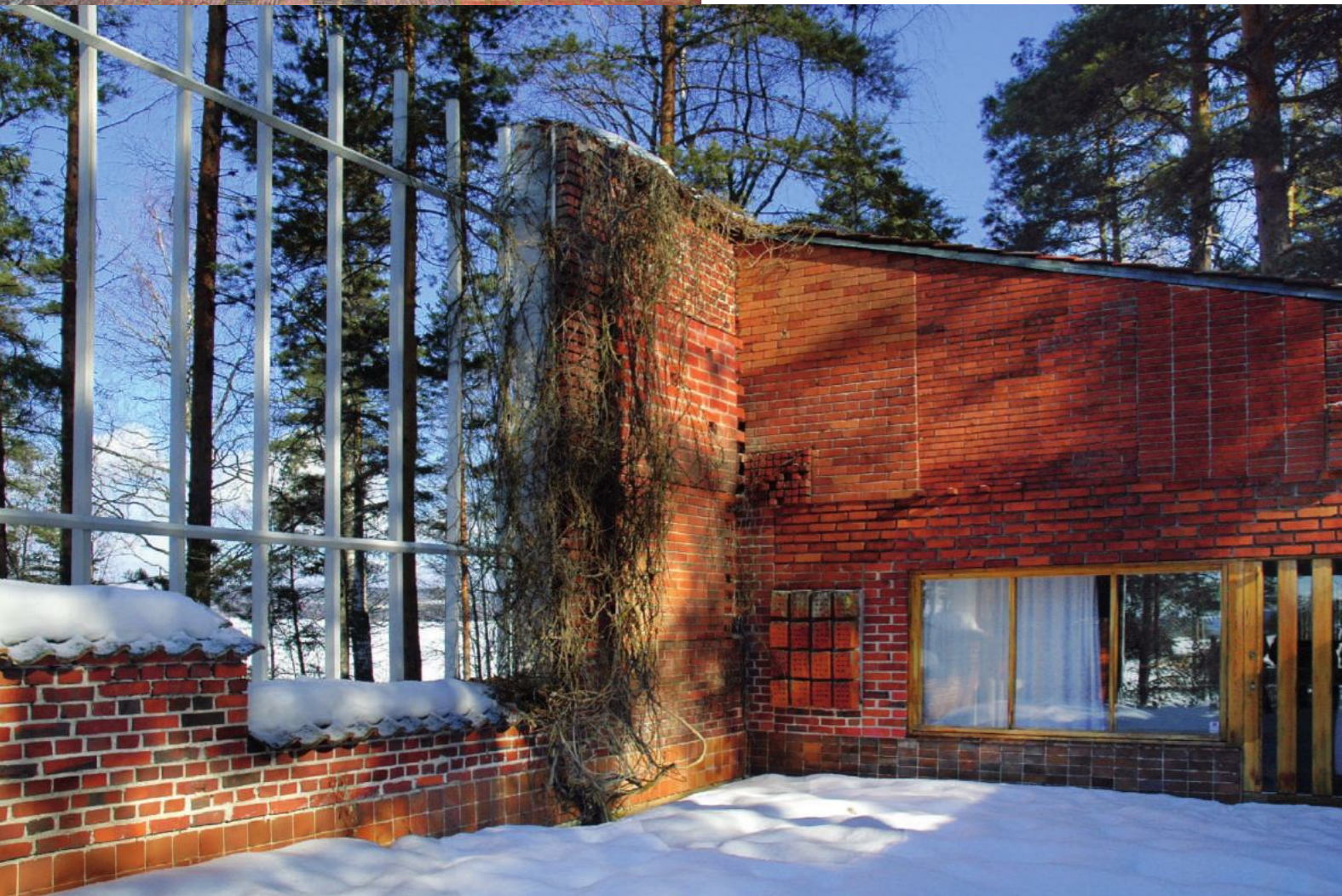
Imagen 29. Vista del patio hacia el hueco oeste.
