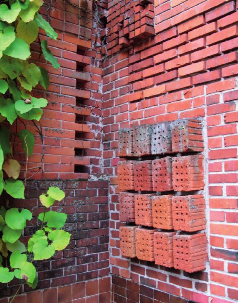
Imagen 33. Detalle de los diferentes aparejos de ladrillo del patio.
