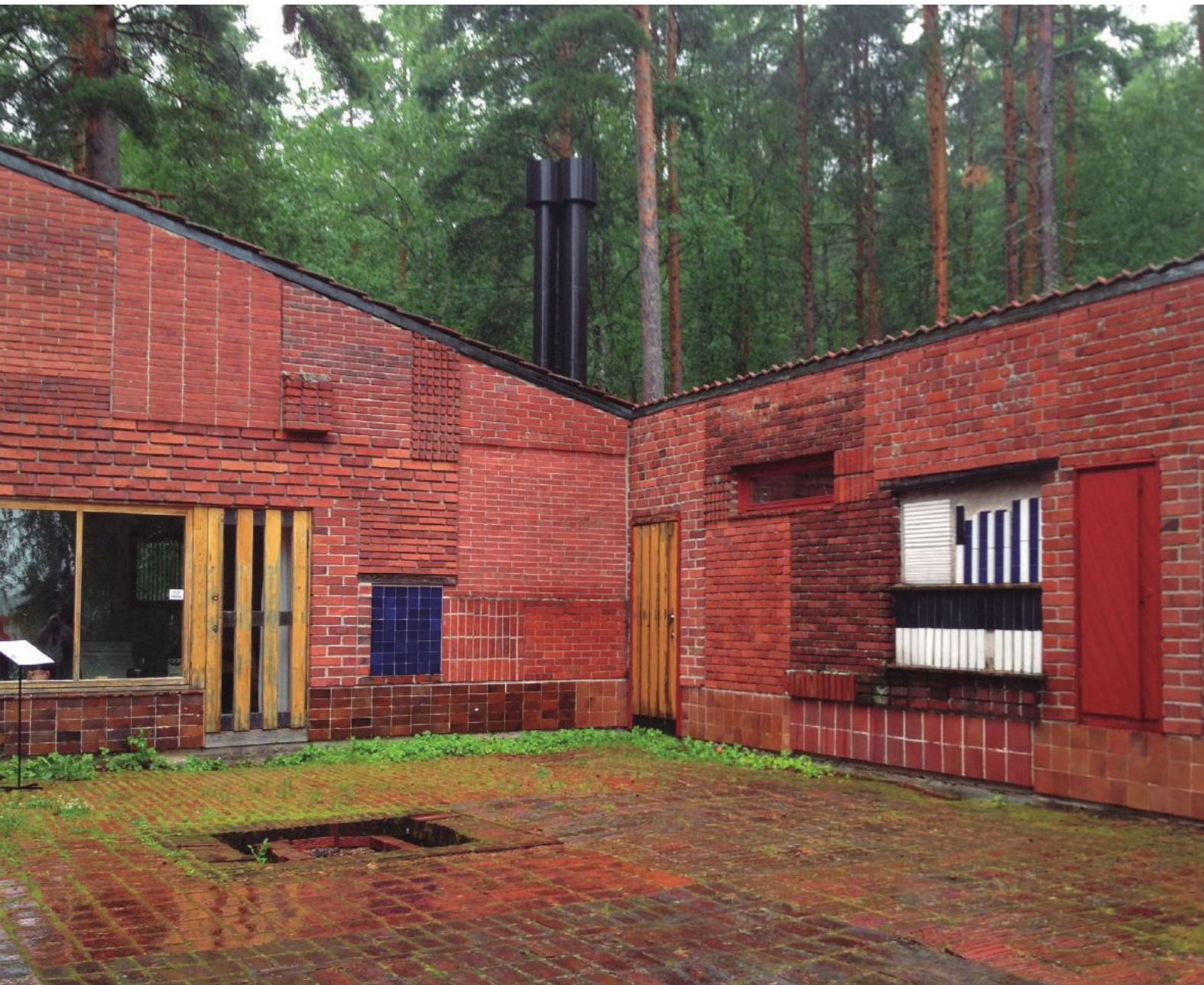
Imagen 30. Vista del patio desde el muro oeste.
