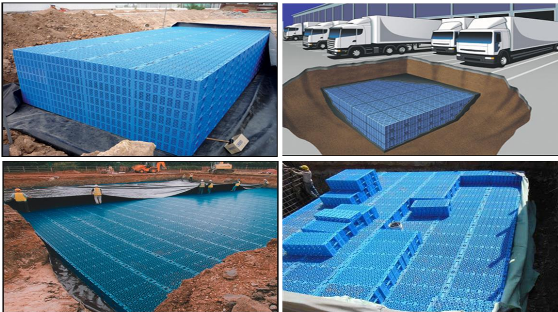
Figura 2. Diferentes vistas de tanques de retención en construcción empleando módulos Aquacell (Akm Consultants, Icai, HidroPluviales, Wavin ).
