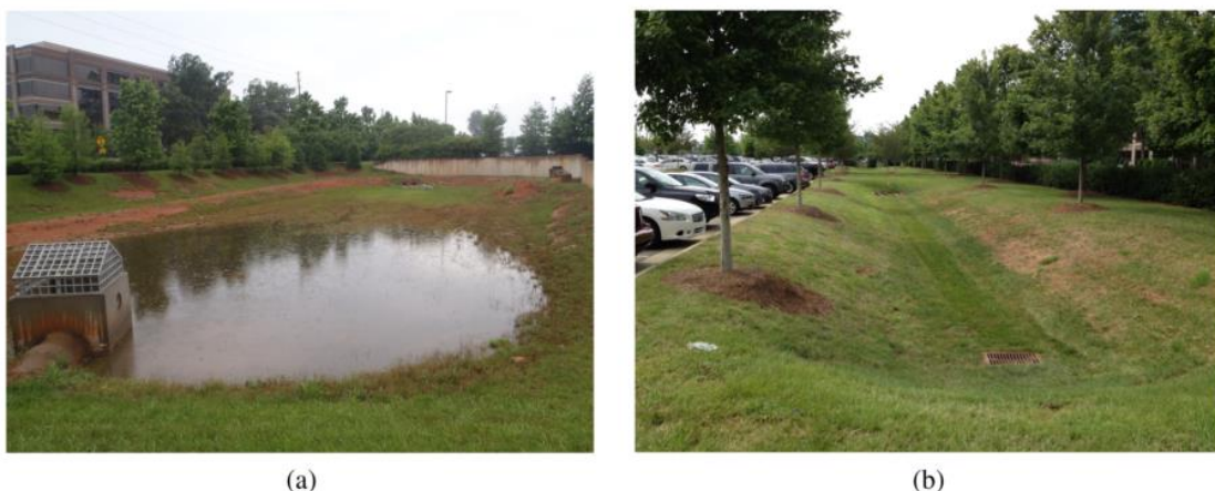
Figura 4.- Características del diseño del desarrollo convencional: (a) cuenca de detención seca con cuneta verde perimetral y estructura de hormigón en salida; (b) zanjas de pretratado.
