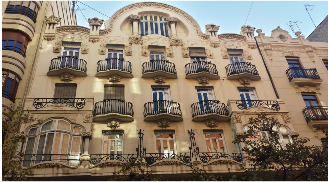
Imagen 33. Fachada de la Casa de José Peris. Fuente: fotografía propia.
