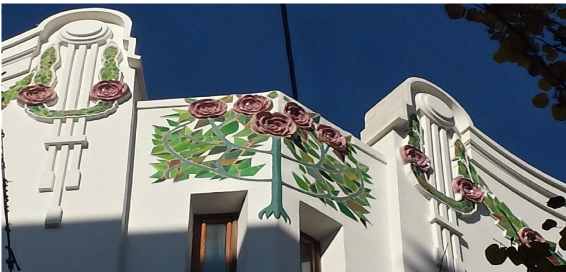
Imagen 22. Detalle de las articulaciones del edificio rematadas en árboles y guirnaldas con formas de rosa. Fuente: fotografía propia.
