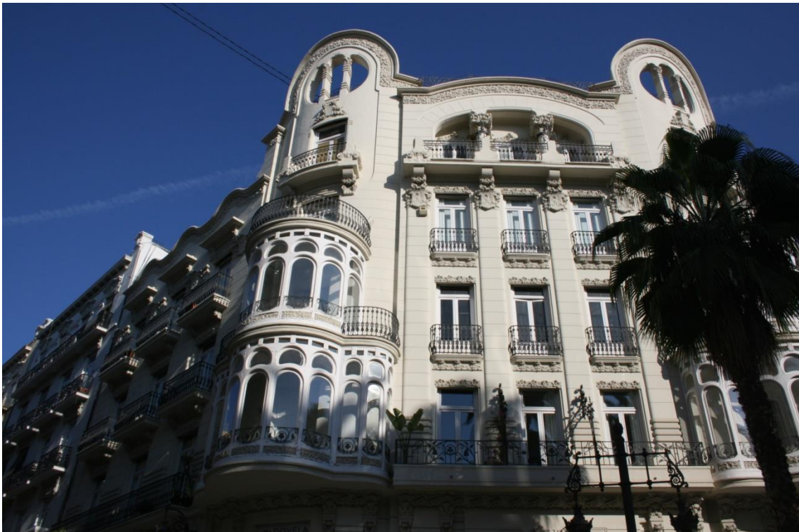
Imagen 35. Fachada principal y lateral de las Casas Chapa. Fuente: fotografía propia.
