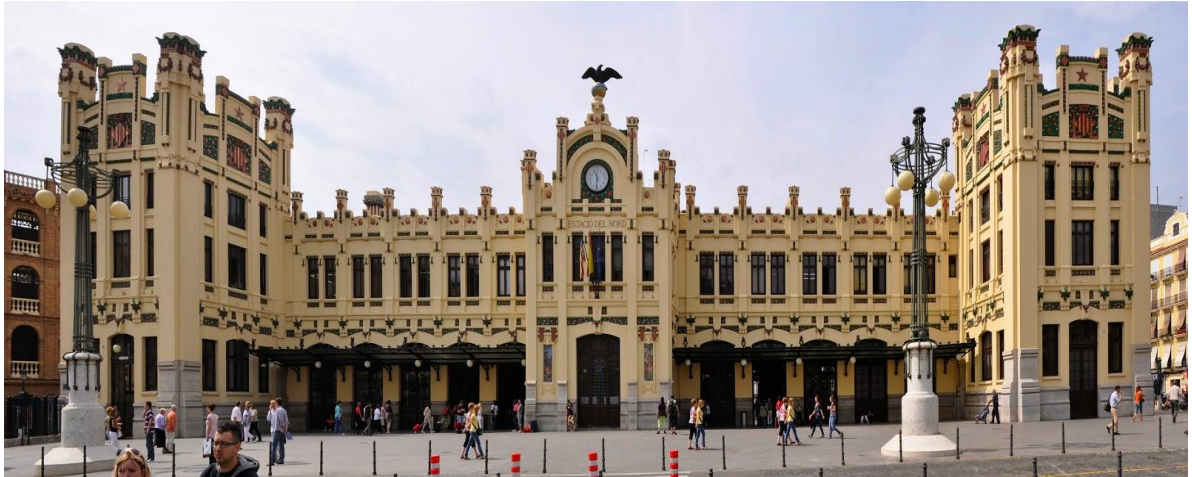
Imagen 11. Fachada y acceso principal de la Estación del Norte de Valencia. Fuente: valenciaarenaycal.blogspot.com.es .
