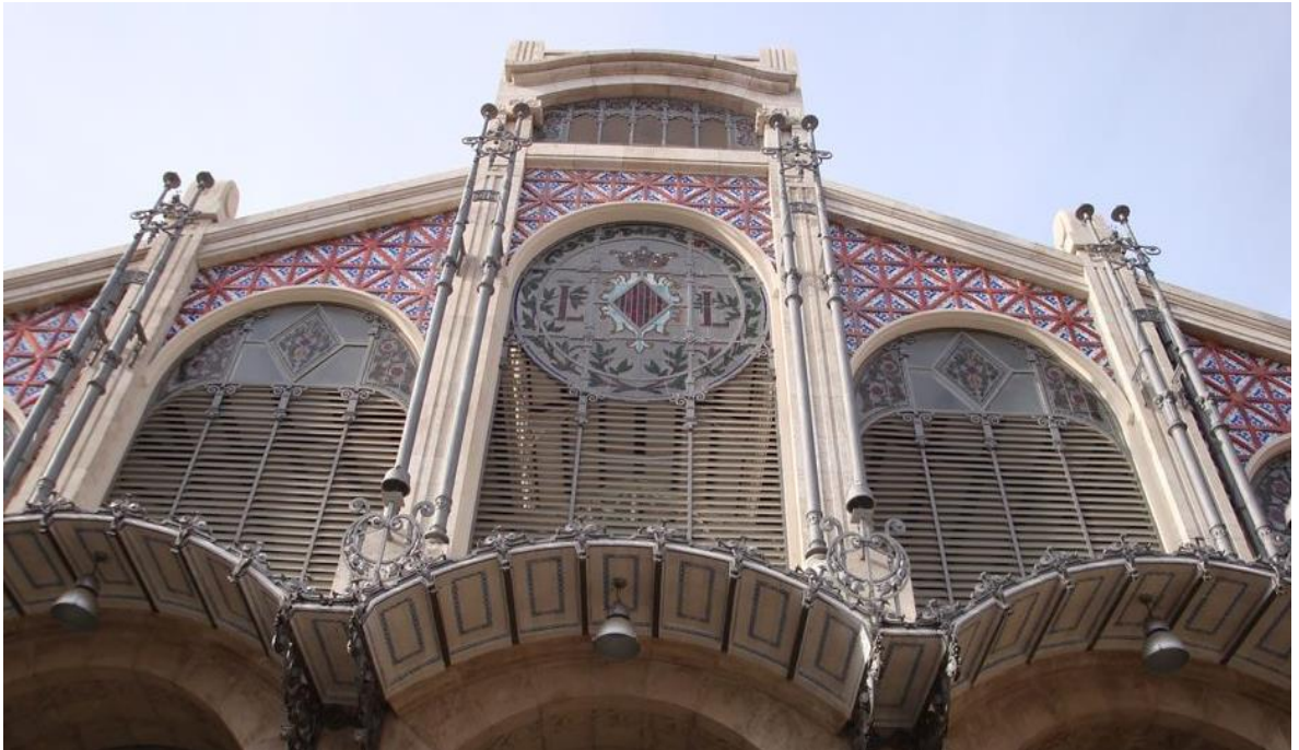
Imagen 3. Fachada principal del Mercado Central con el escudo. Fuente: www.mercadocentralvalencia.es .
