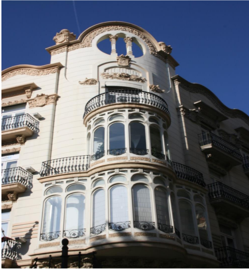
Imagen 36. Detalle de los balcones, forja y firma del arquitecto. Fuente: fotografía propia.
