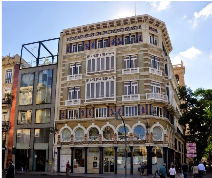
Figura 5: GARCÍA CARDONA, Lucas, Los almacenes isla de Cuba , 1887. Fotografía del edificio.
