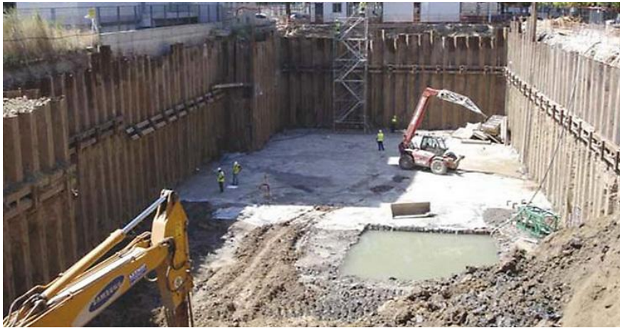
Ilustración 9. Pérez (2015). Ejemplo pantalla de tablestacas de hormigón
