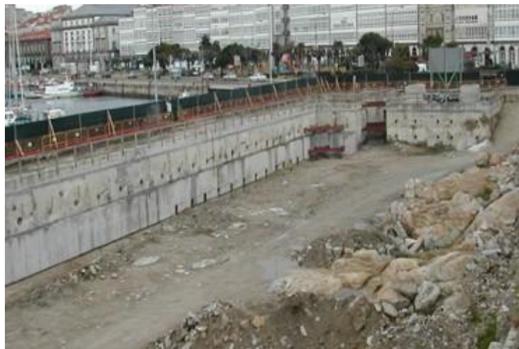
Ilustración 7. Pérez (2015). Pantalla continua de hormigón
