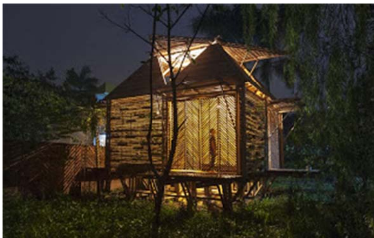
Fig.20. Casa de bambú en Guatemala, 2013. (Fuente: Paniagua, 2013)
