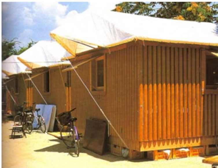
Fig. 7. Alojamientos de emergencia realizados en Kobe (Japón). (Fuente: Quintal, 2014)
