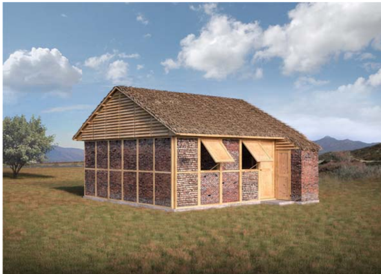
Fig. 13. Asentamientos diseñados por Shigeru Ban para las víctimas del terremoto de Nepal. (Fuente: ARQ Social, 2015)
