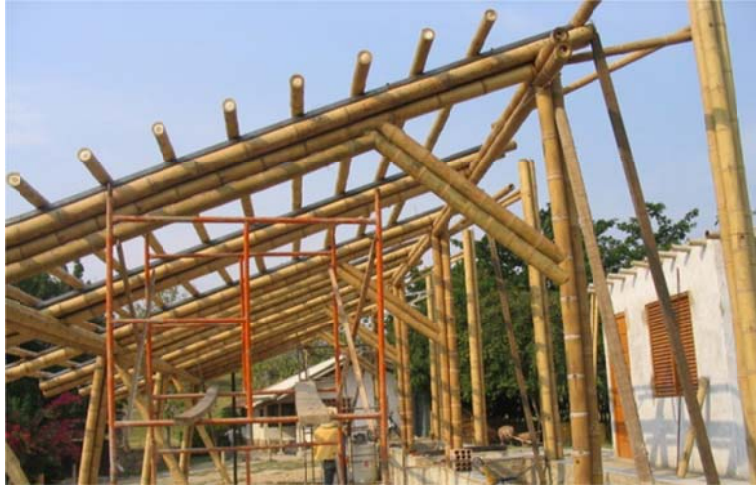
Fig.10. Casa construida con bambú, 2015. (Fuente: www.imagui.com )
