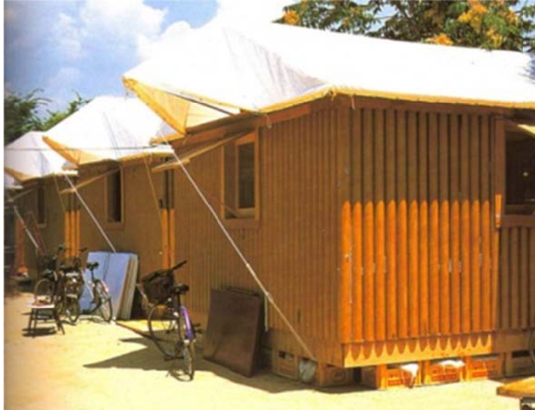
Fig. 27. Paredes de tubo de cartón. Shigeru Ban. Kobe (Japón). (Fuente: https://www.google.es/search?q=Shigeru+ban.+Refugios+en+Kobe+(japon).&biw=1536&bih=755&tbm=isch&imgil=9KJlyge2zdIHM%253A%253Bjlr-Q )
