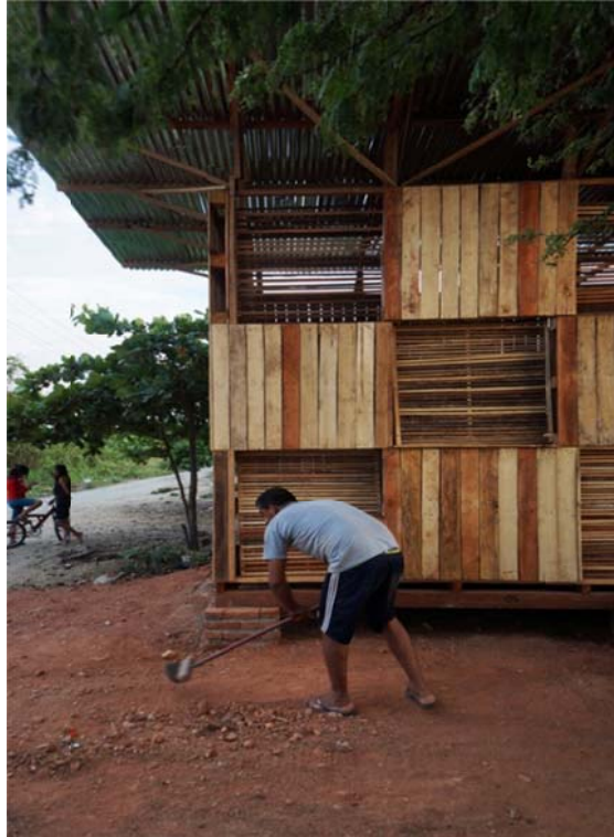
Fig. 25. Construcción de refugio mediante Pallets reutilizados. Ecuador, 2016 (Fuente: Plataforma Arquitectura)
