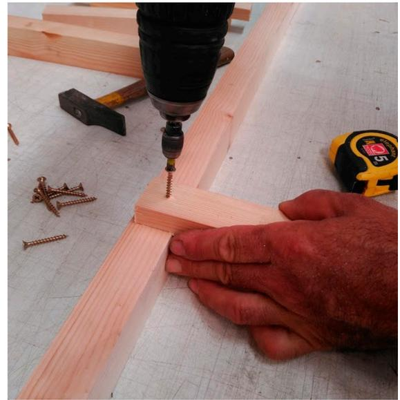
Figura 156. Fijación con el tirafondo
