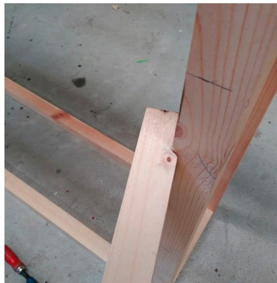
*Figura 167. Corte de la muesca para la unión entre el colector y la cámara de secado*
