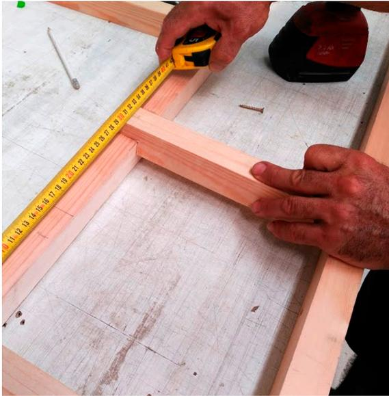
Figura 155. Medida para la colocación
