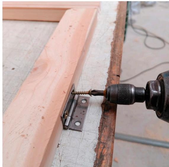
Figura 163. Colocación de la bisagras
