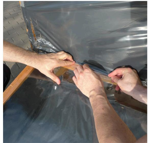
Figura 80. Sellado de la unión del plástico
