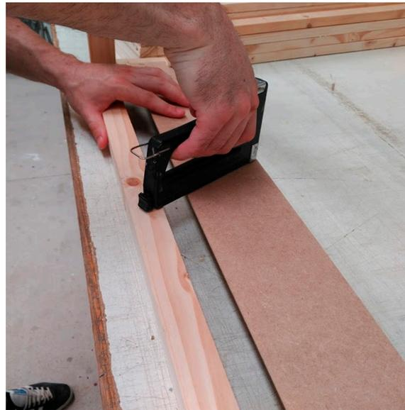
*Figura 174. Grapado de la lámina de DM en el colector*
