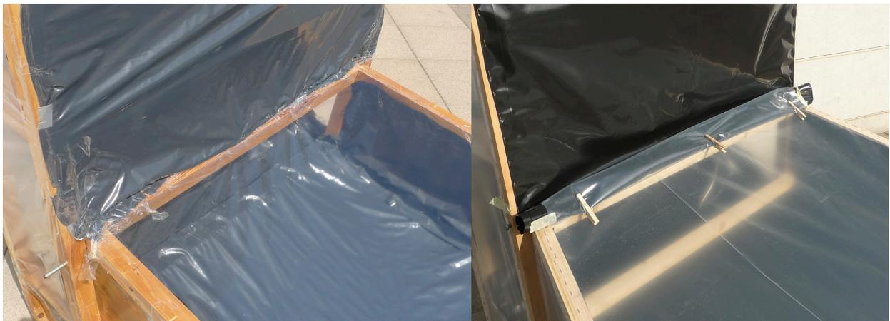
Figura 193. Unión de la cámara de secado con el colector
