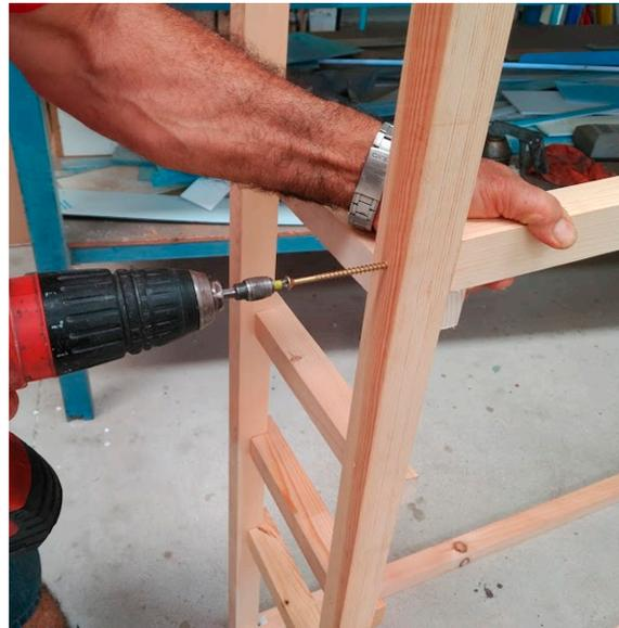
*Figura 158. Montaje de las traveseras*
