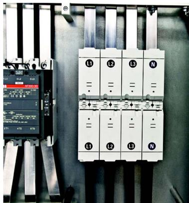
4. Conecte N, L1, L2 y L3 según indique la leyenda en los bornes de conexión "MC-X3 PV-System".
