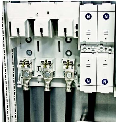
10. Coloque la cubierta de los bornes de conexión L1, L2 y L3 y apriete los tornillos.
