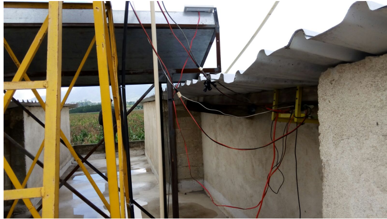
Figura 27: Central de datos en funcionamiento
