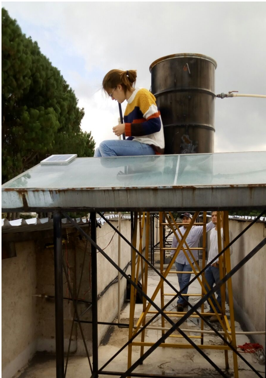
Figura 26: Instalando la célula fotovoltaica
