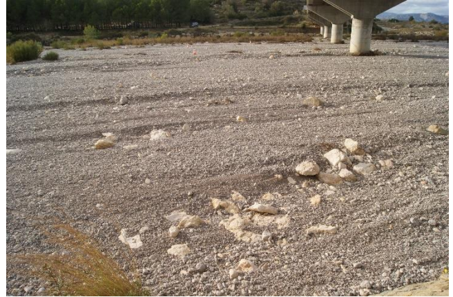
Ilustración 45. Primera fotografía de la pasada 2 de la zona B del Puente Cervera.
